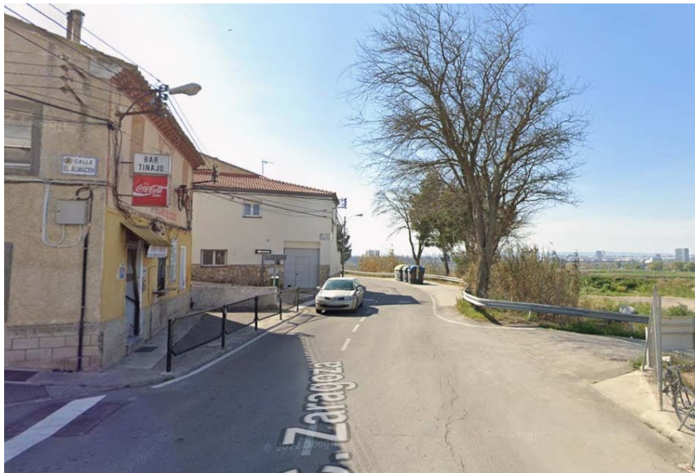
Imagen 10. Tramo 4. Luminarias en fachada a 6 metros de altura y canalización aérea.
