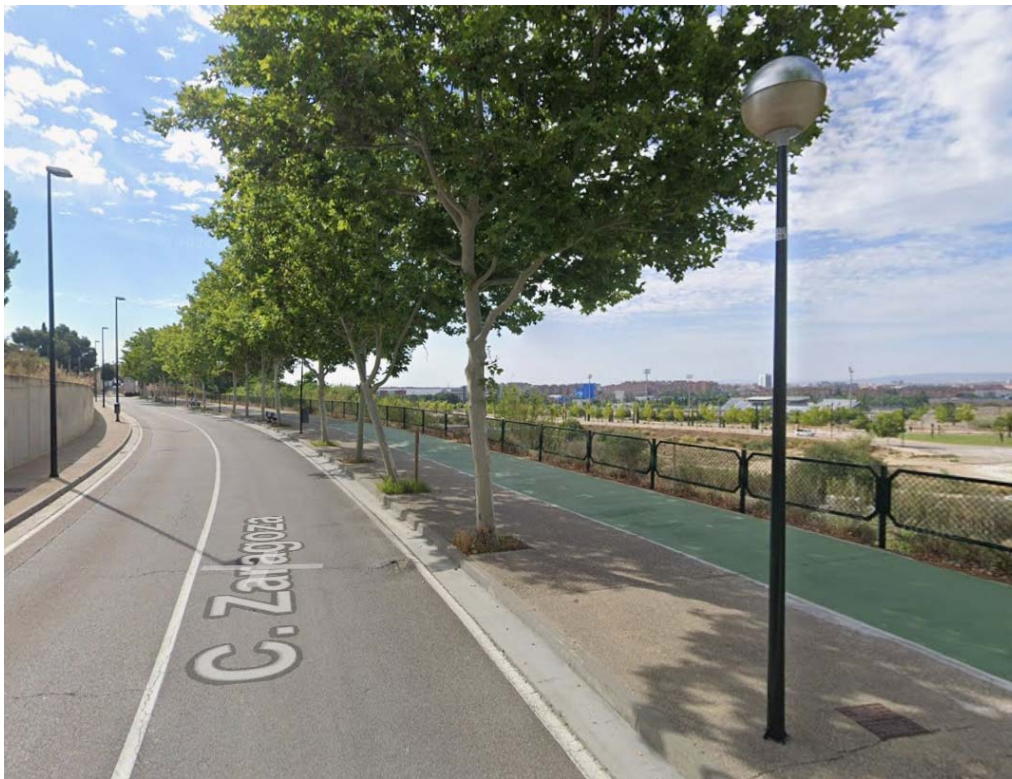
Imagen 11. Tramo 5. Luminarias tipo vial y tipo globo a tresbolillo.
