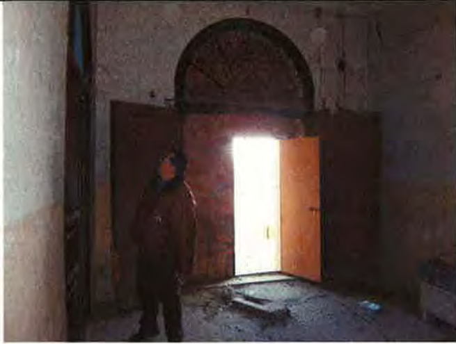
Puerta principal desde el interior
