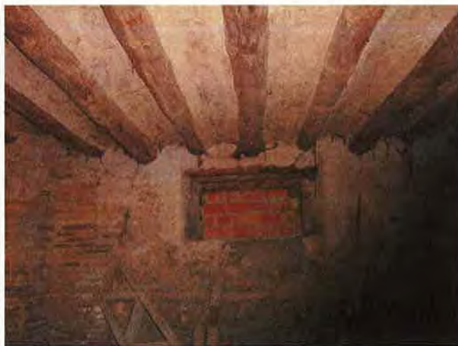
Forjado techo sótano. Ventana a Tercer Cinturón
