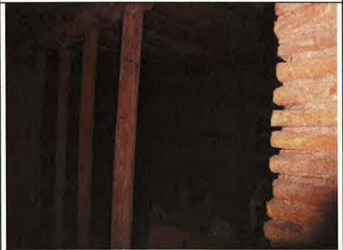
Forjado techo sótano. Viga central apuntalada
