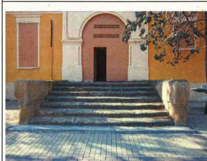
Escalera de acceso a edificio
