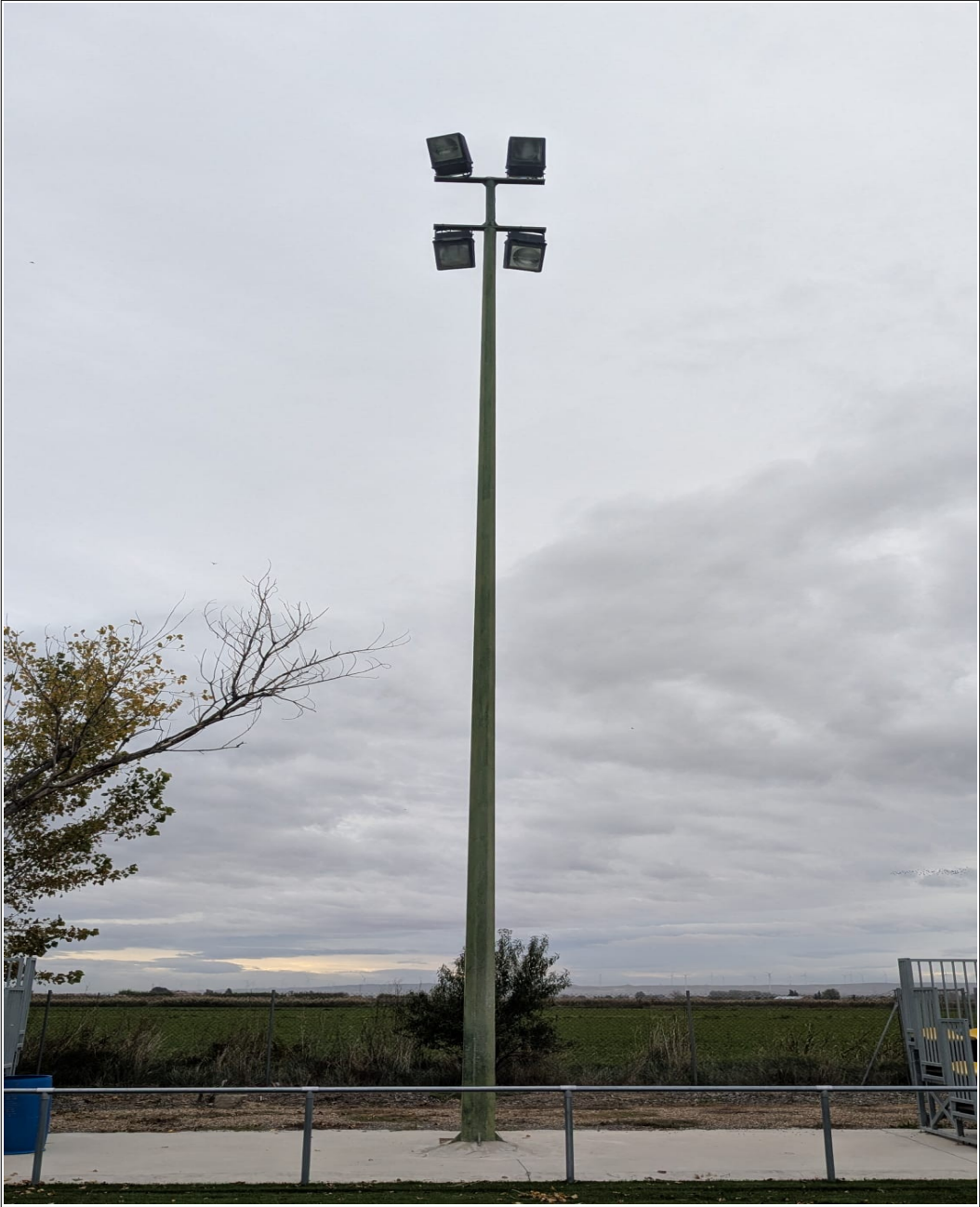
Báculo de Acero a 2 alturas de 12 metros y 14 metros con 4 focos
