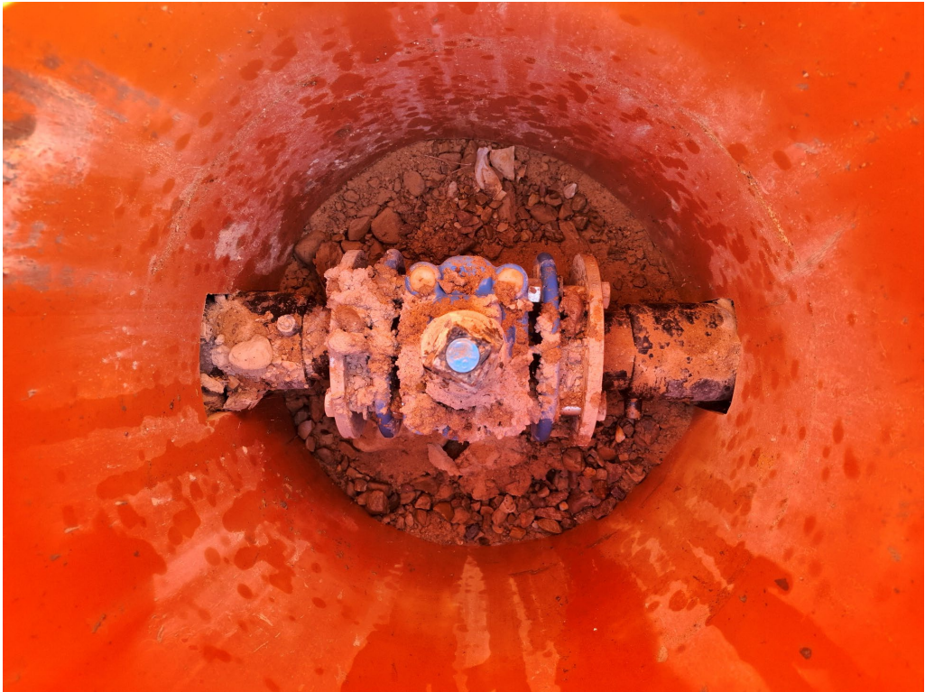
Llave de toma existente. Realizada en 63 mm desde el anillo de riego de 140 mm de Parque Venecia.
