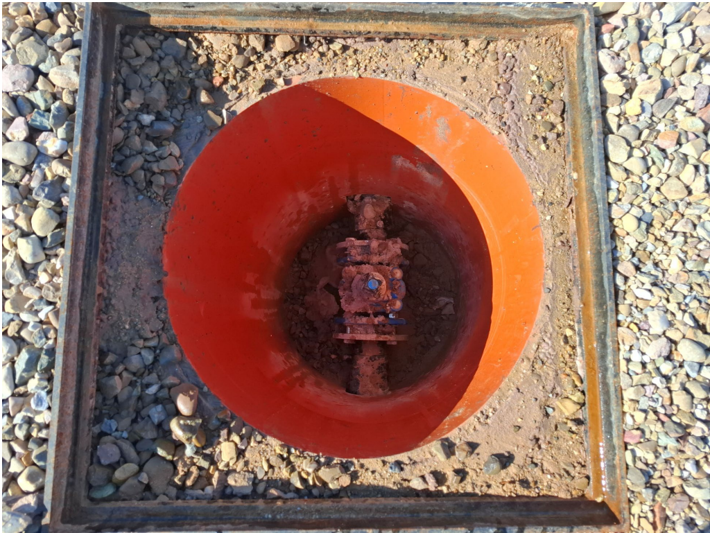
Llave de toma existente. Realizada en 63 mm desde el anillo de riego de 140 mm de Parque Venecia.
