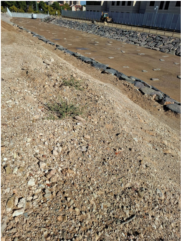
Talud Zona 1. A revegetar.
