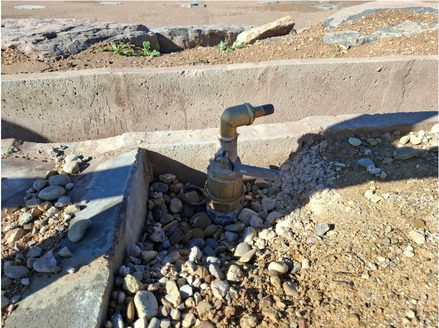
Tallo de la toma de agua durante la obra en el lateral izquierdo del camino junto a canal.
