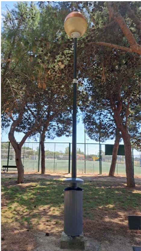
Imágenes 3 y 4. Luminaria tipo globo de v.s.a.p. existentes en el parque junto a la calle Jesús y María.
