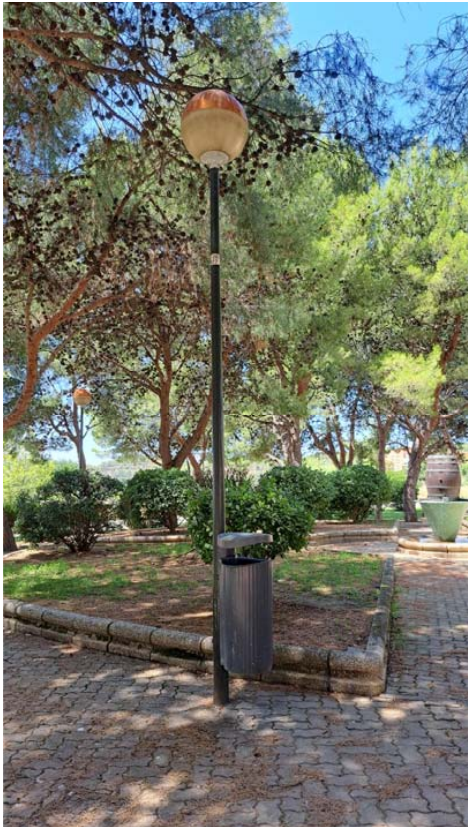
Imágenes 5 y 6. Luminaria tipo globo de v.s.a.p. existentes en el parque junto a la calle Jesús y María.
