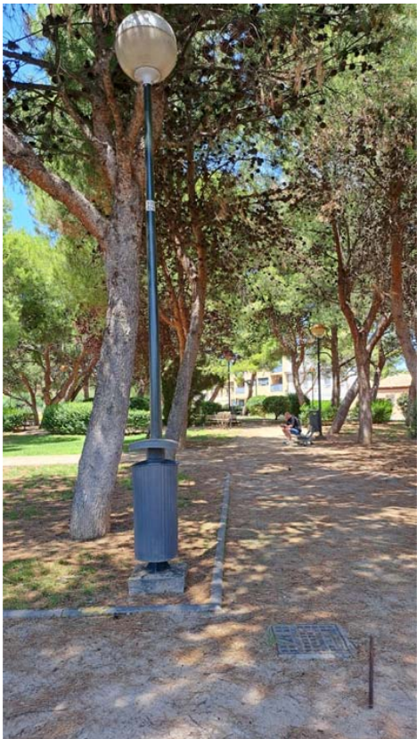
Imágenes 3 y 4. Luminaria tipo globo de v.s.a.p. existentes en el parque junto a la calle Jesús y María.
