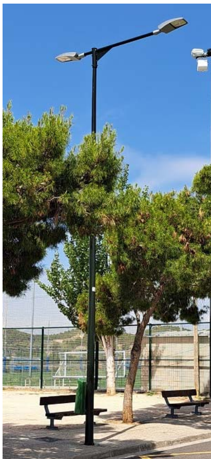
Imagen 11. Columna con cruceta metálica y brazo de 1,5 metros en luminarias previas instaladas en la continuidad de la calle.
