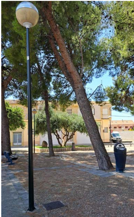
Imágenes 8 y 9. Luminaria tipo globo de v.s.a.p. existentes en la plaza Ramón Sainz de Varanda.
