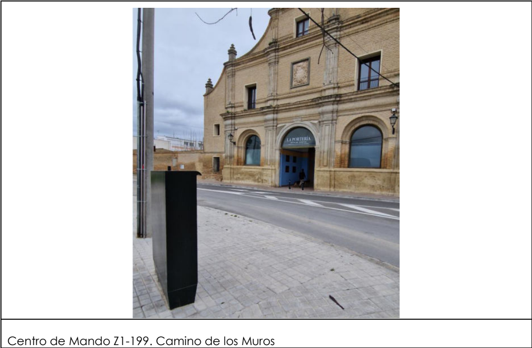
Centro de Mando Z1-199. Camino de los Muros
