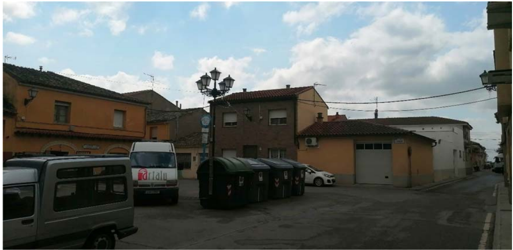
Imagen 12. Plaza del Carmen. Luminarias perimetrales en fachada.
