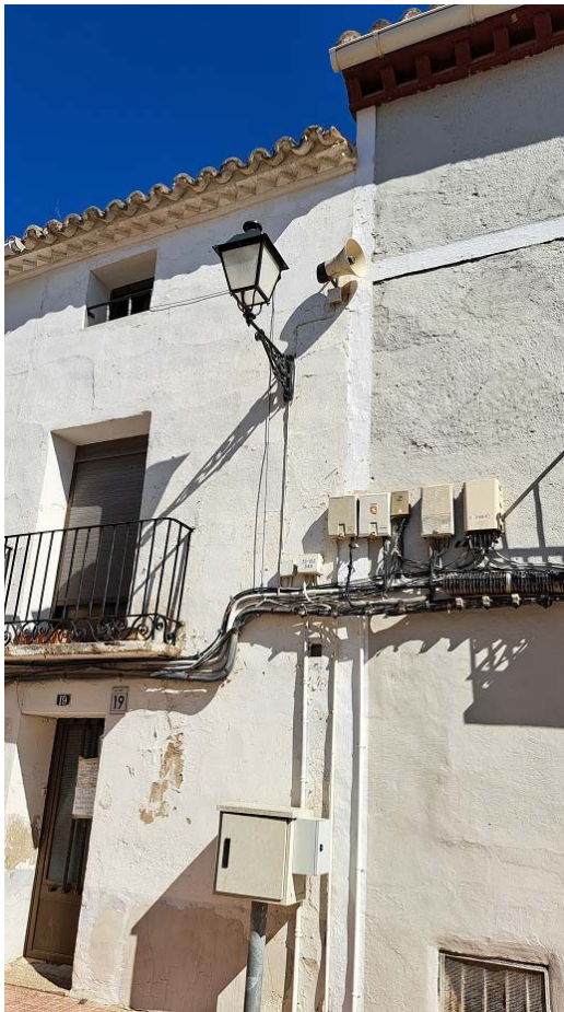
Imagen 4. Plaza de España. Luminaria perimetral ubicada en fachada de calle de La Cruz. Paso subterráneo – aéreo.
