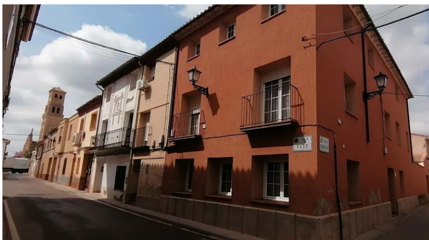
Imagen 20. Luminarias en calle de El Paso.
