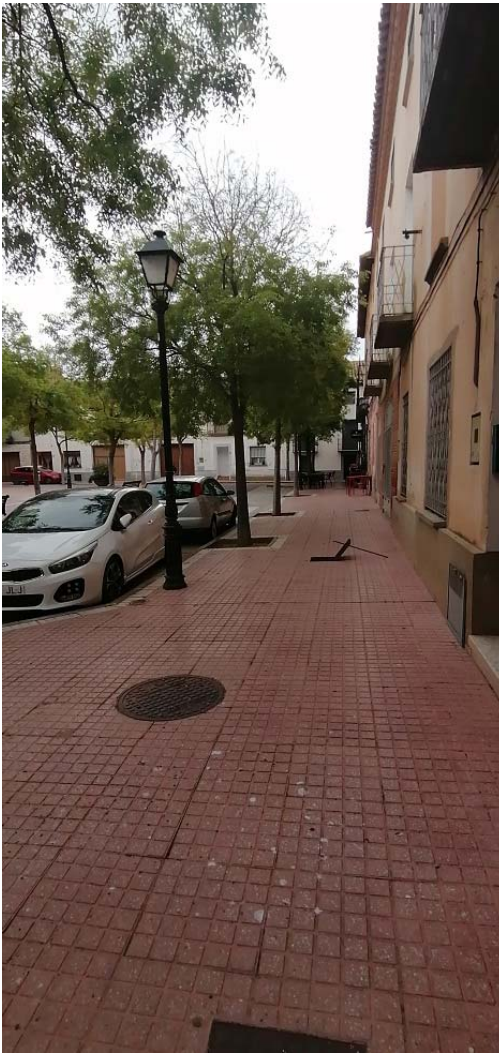
Imagen 2. Plaza de España. Luminarias zona perimetral en acera. Columnas con 1 farol.
