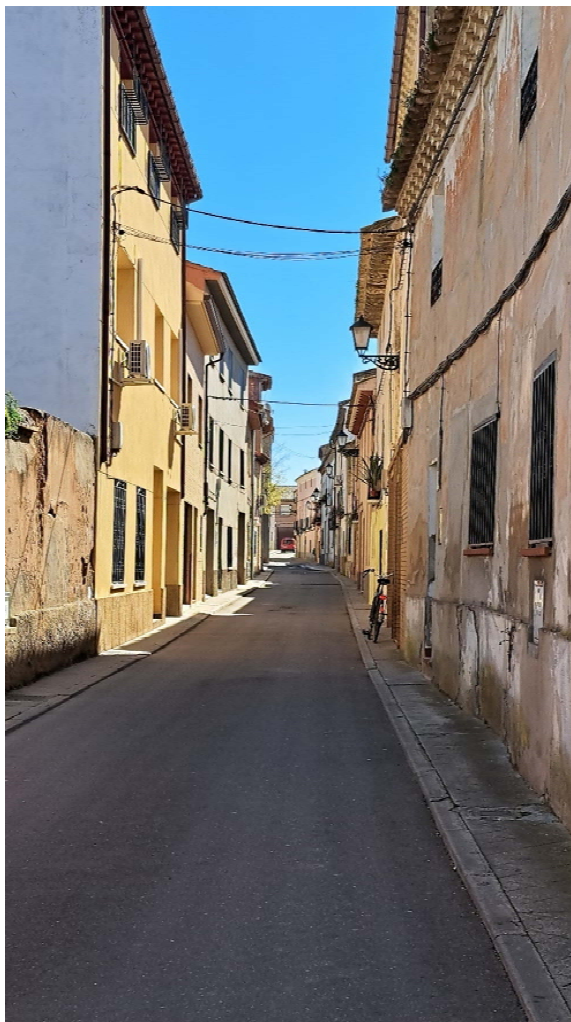
Imagen 19. Luminarias en calle de Enmedio.
