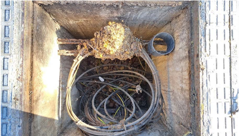
Imagen 3. Interior de arqueta en calle Mayor.
