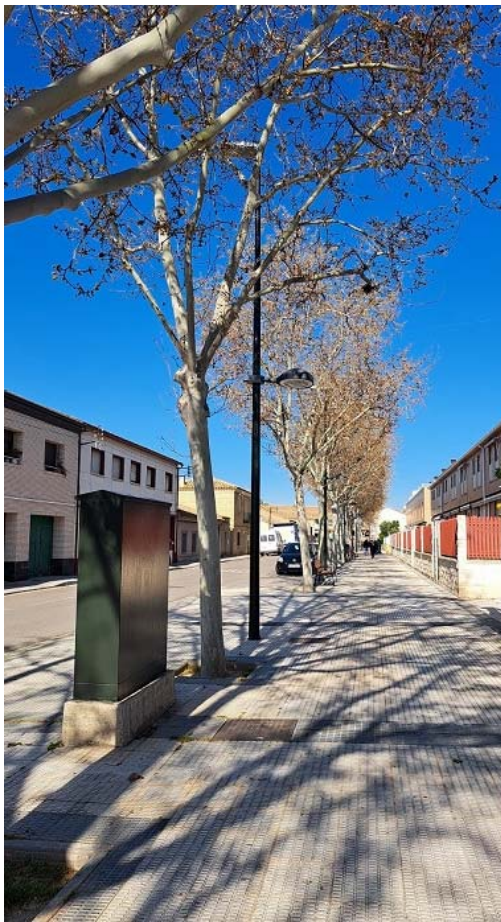
Imágenes 1 y 2. Tramo 1, calle Mayor. Centro de mando de alumbrado y luminarias.
