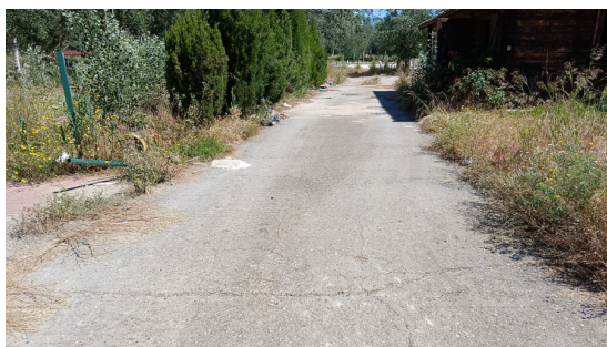
Accesos a demoler.
