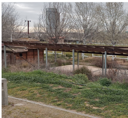
Antigua casetas de taquilla-almacén
