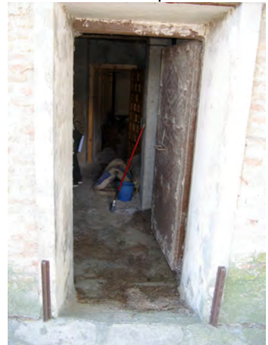
Entrada desde fachada trasera a almacén aperos
