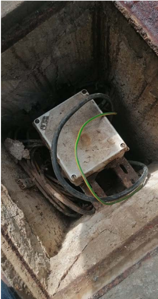
Imagen 4. Arqueta en tramo 1, paseo de La Sagrada.
