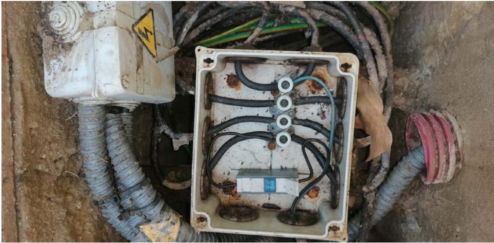
Imagen 3. Arqueta en tramo 1, paseo de La Sagrada.
