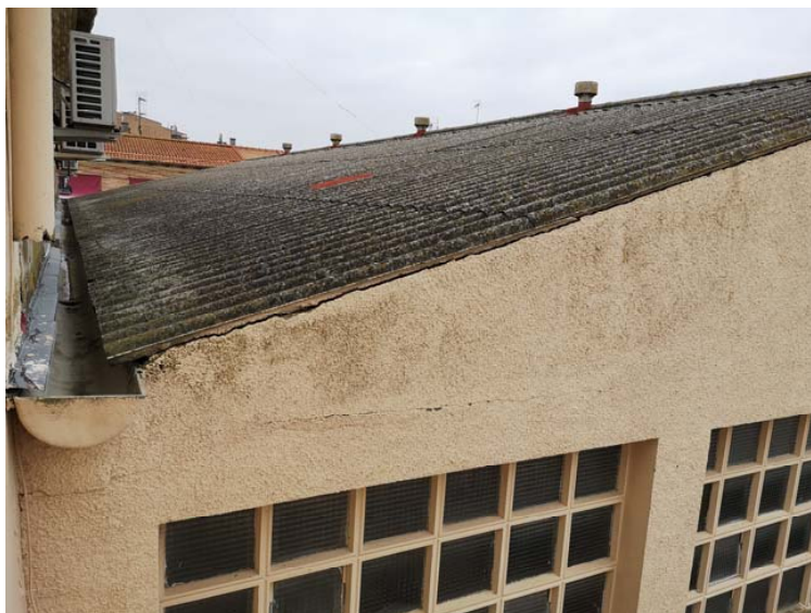
Vista detalle cubierta pabellón encuentro con fachada Centro Cívico
