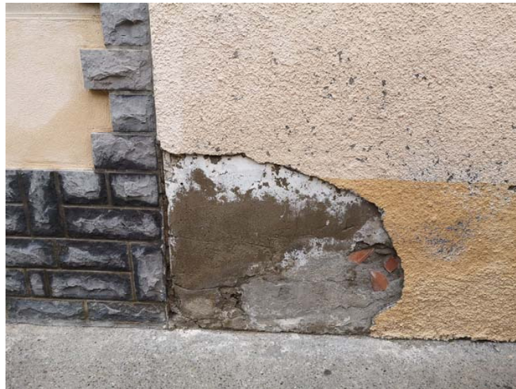
Vista detalle estado fachada planta baja Pabellón
