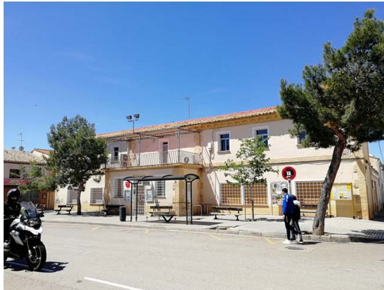
Fachada Plaza España
