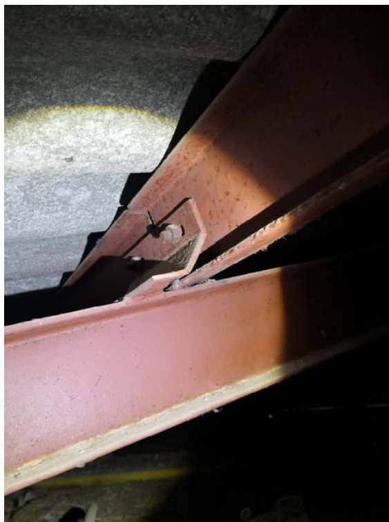
Detalle del estado de la estructura de cubierta del Pabellón
