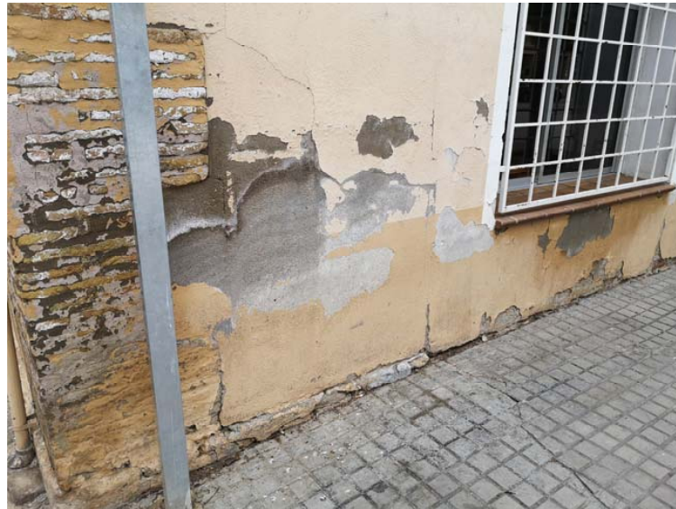
Vista detalle estado fachada planta baja edificio Centro Cívico
