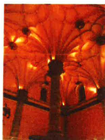
Bóvedas de crucería
