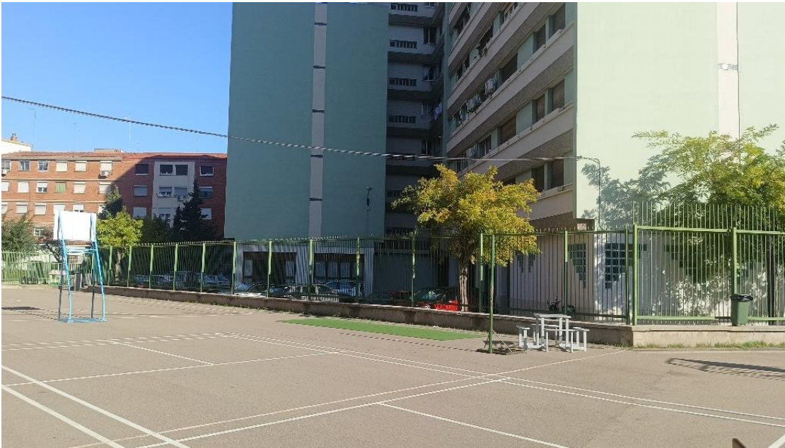
Zona de ágora bajo cubierta en primaria
