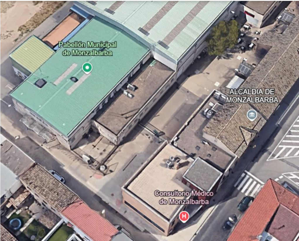
Vista panorámica de zona afectada
