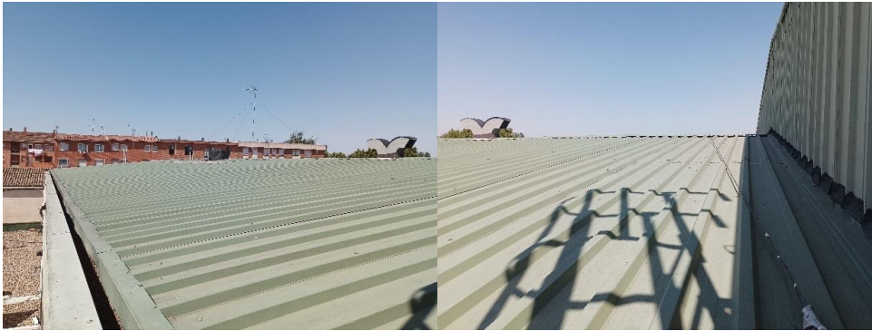
Cubierta inclinada para instalación fotovoltaica
