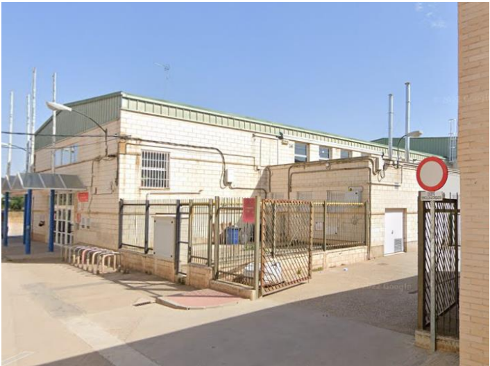
Zona de afección para instalación fotovoltaica
