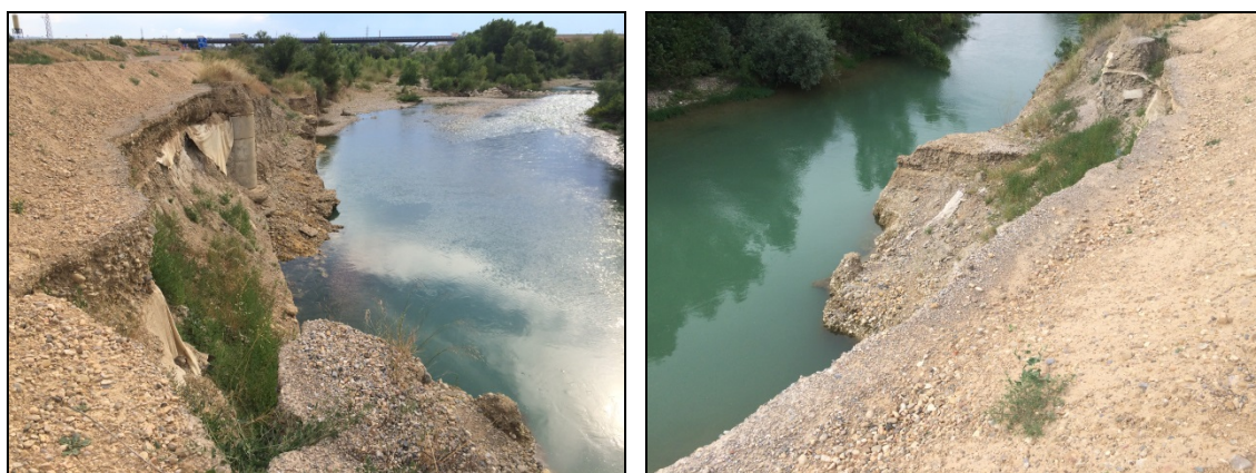
Imágenes del talud a reparar
