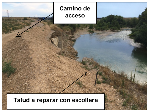
Detalle del talud a reparar
