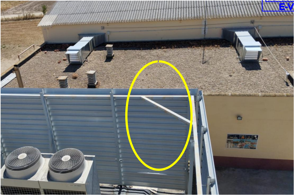
Zona apertura de puerta en vallado de lamas existente visto desde el interior
