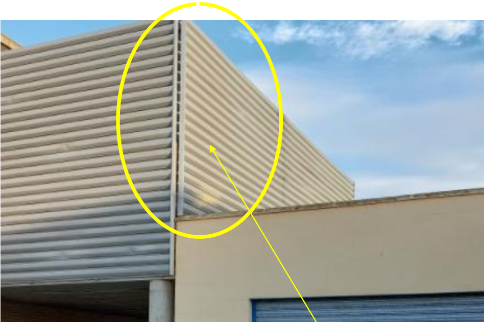
Zona apertura de puerta en vallado de lamas existente visto desde el exterior
