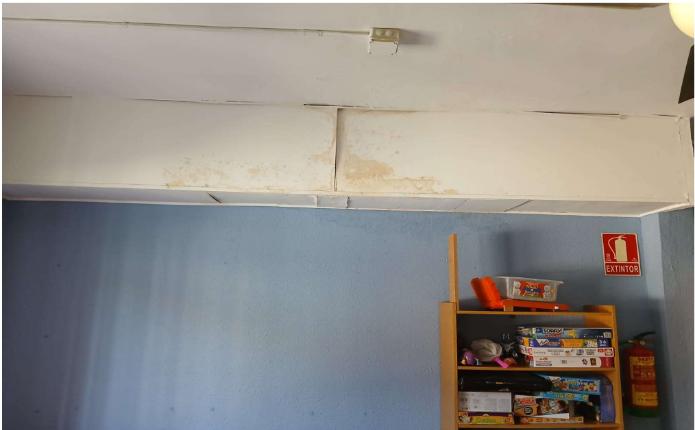
Cajón para tapar instalaciones
