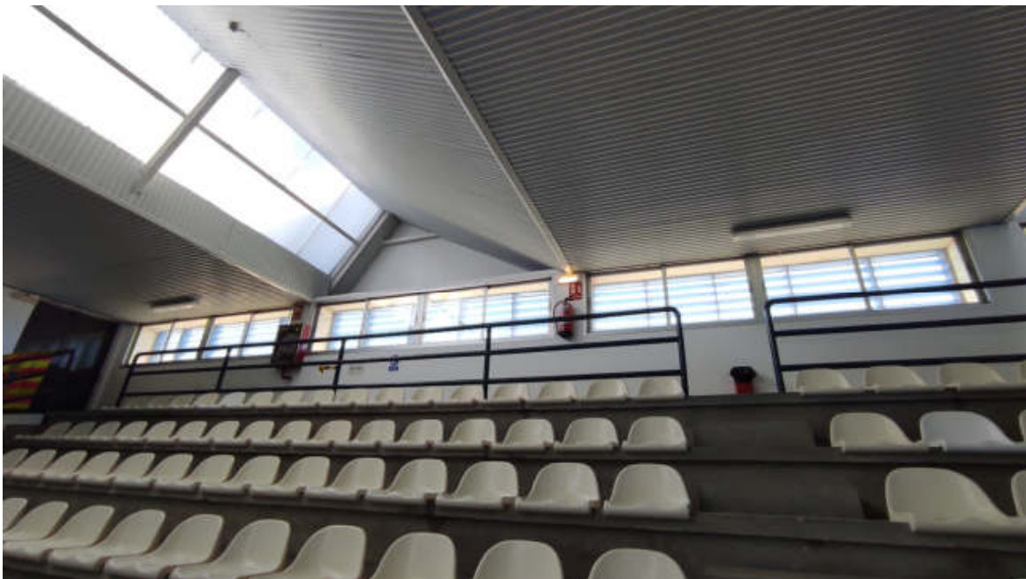
Foto 2 (Zona de gradas)
