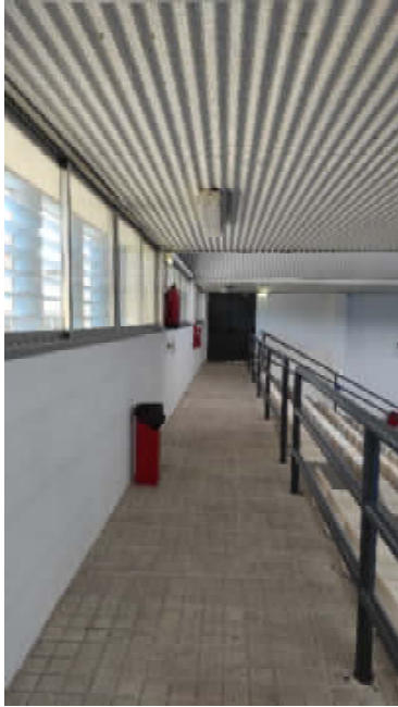
Foto 3 (Zona de gradas)
