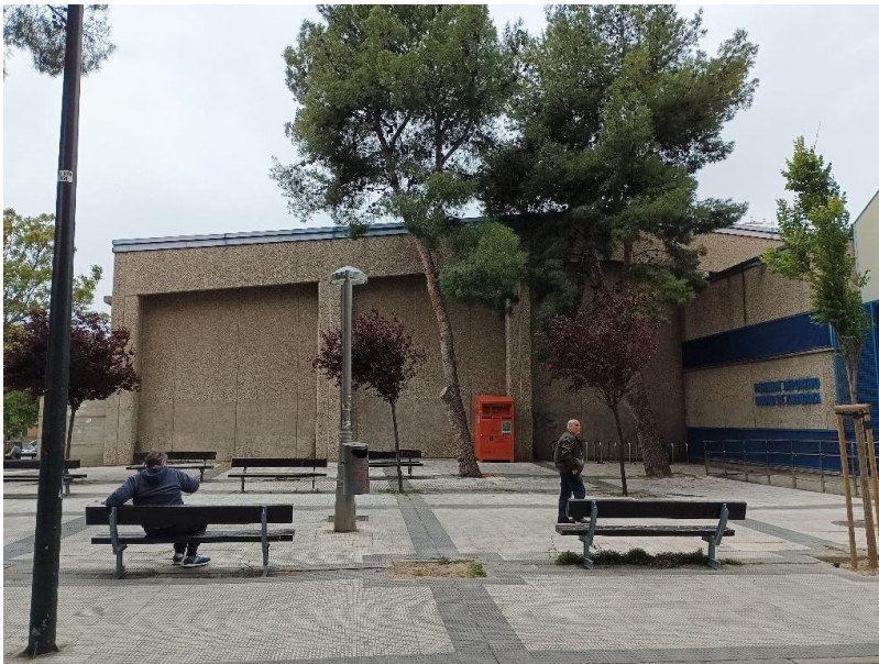
Fachadas CDM CIUDAD DE ZARAGOZA
