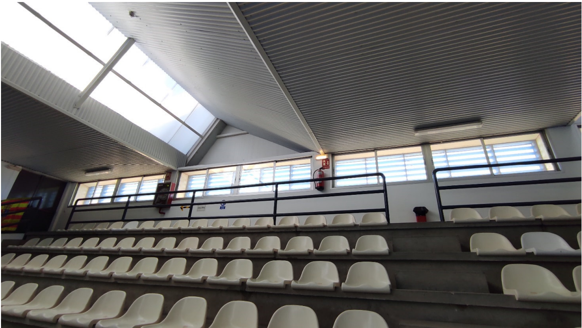
Foto 2 (Zona de gradas)
