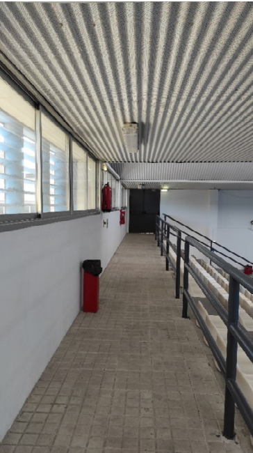
Foto 3 (Zona de gradas)
