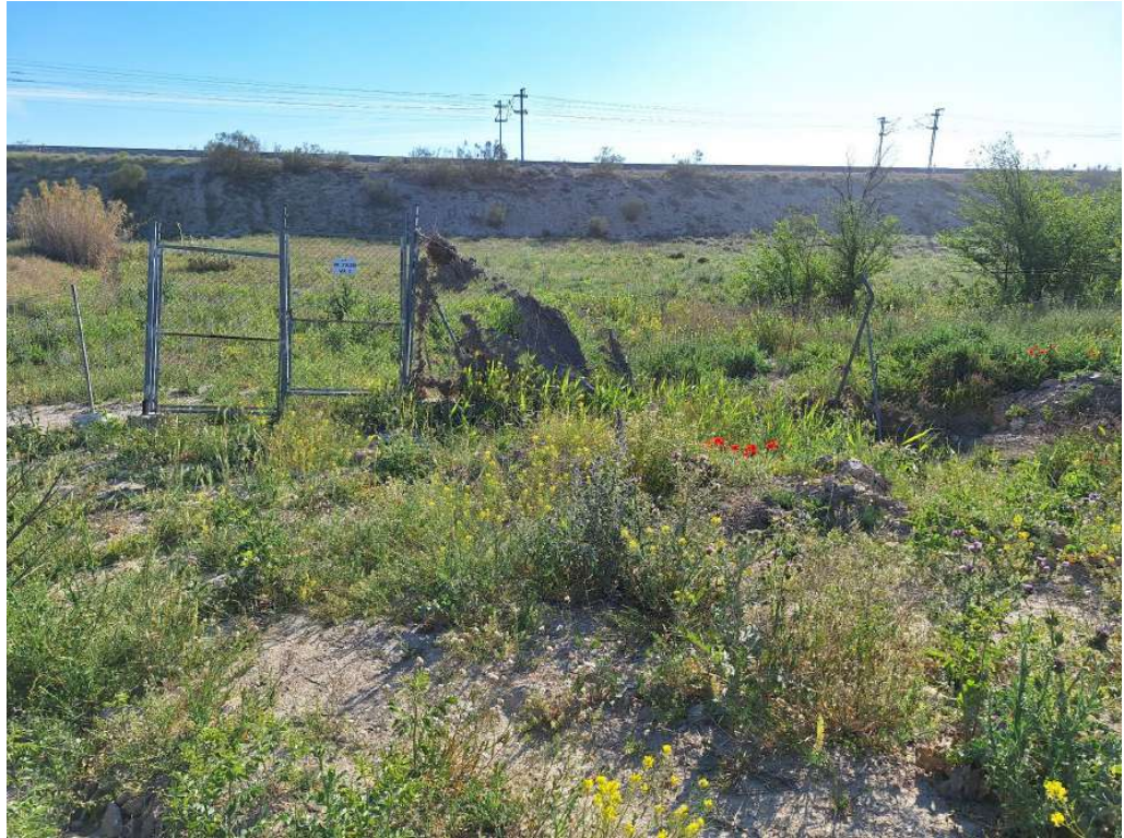
Valla del AVE. Al día de la fecha se observa todavía restos vegetales que indican el nivel del agua.
