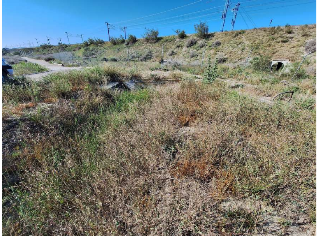
Vista de los drenajes transversales desde el otro lado del AVE
