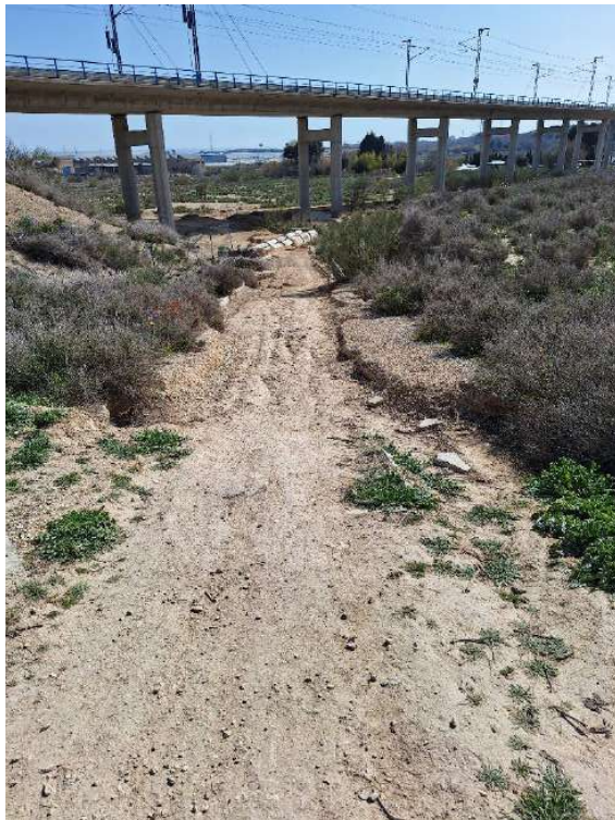
Descalzamiento de camino y erosión por la corriente que toma dirección al viaducto AVE.
