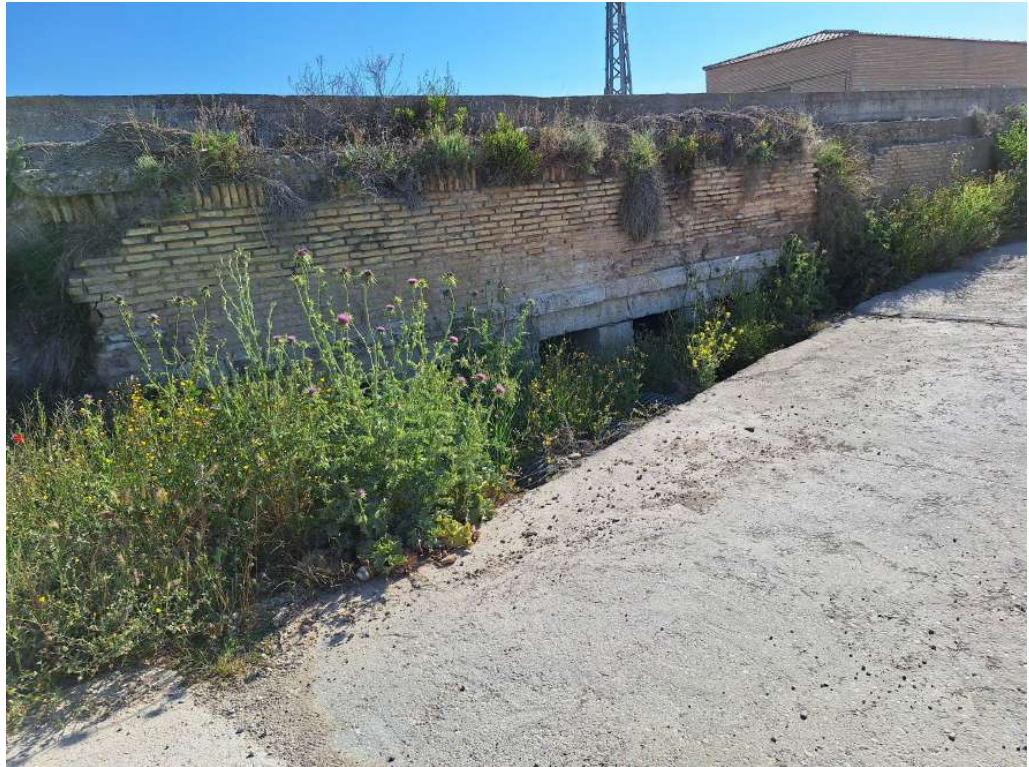
Pasos bajo acequia del Canal Imperial de Aragón y camino de margen derecha.
