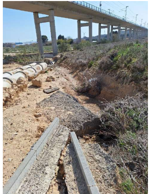
Descalzamiento de camino y erosión por la corriente que toma dirección al viaducto AVE.
