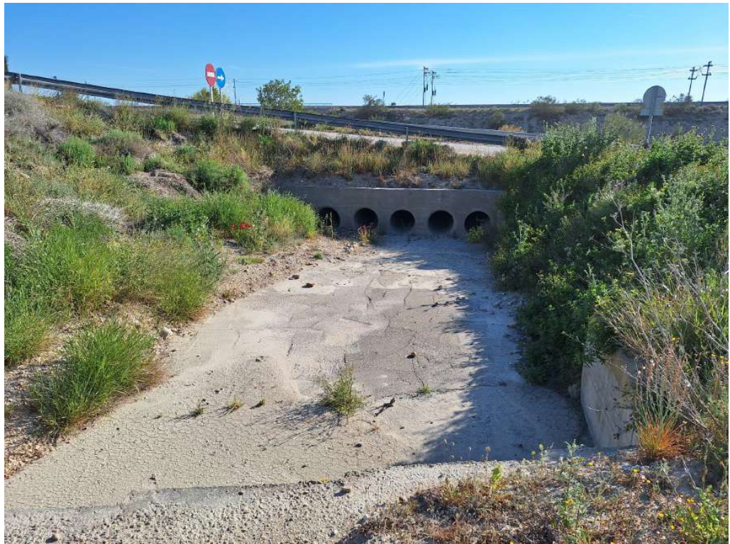
Paso bajo carretera de acceso a INSIDER.
