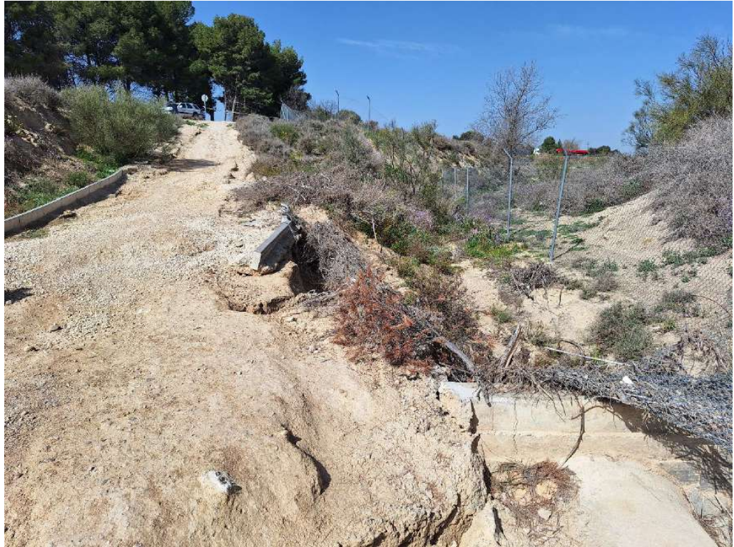
Cauce que toma la escorrentía que no atraviesa los drenajes transversales del AVE
