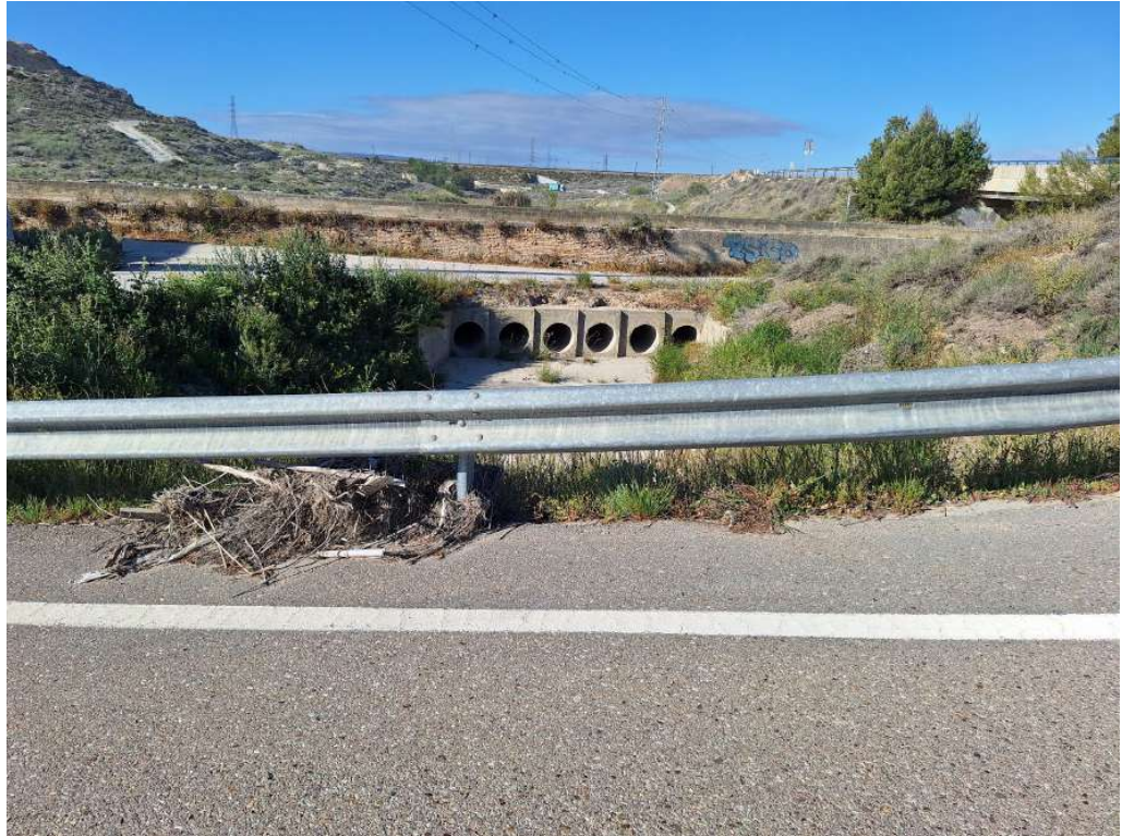
Salida de tubos bajo acequia del Canal Imperial de Aragón y camino de margen izquierda. Se observan todavía restos de la torrencialidad.
