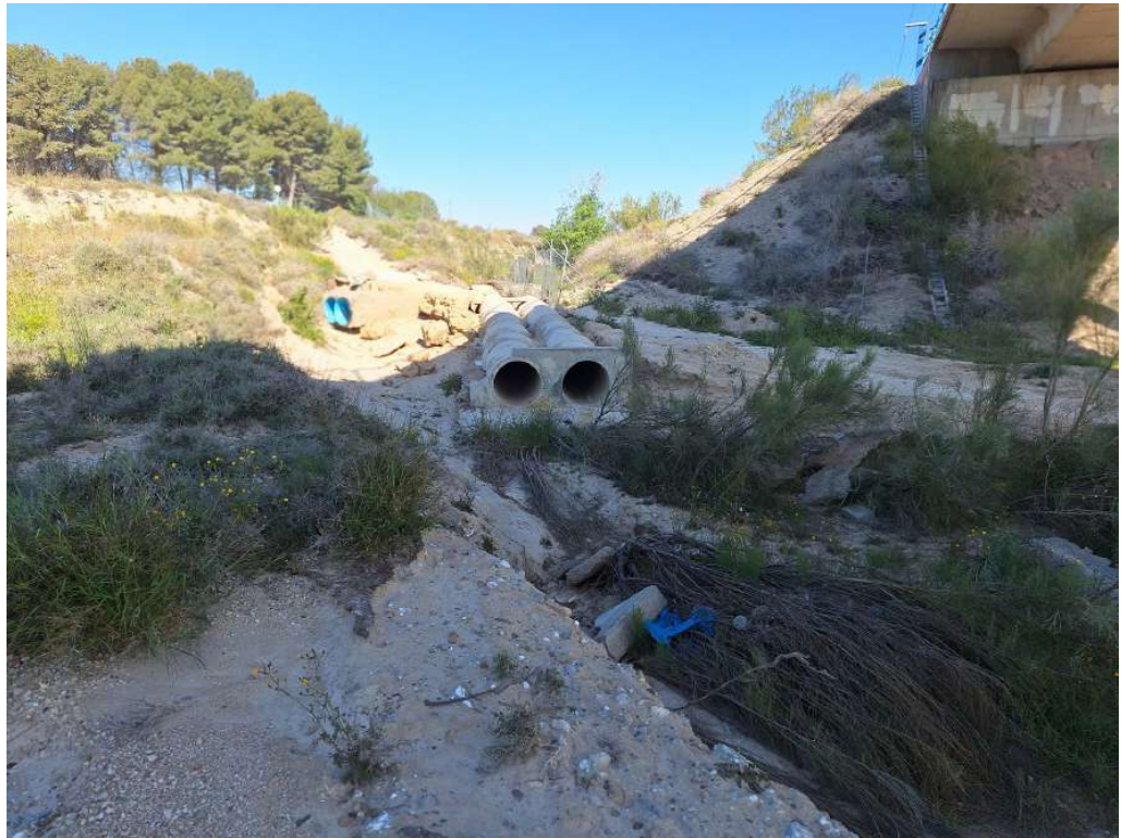
Vista de los tubos de drenaje del camino del Anillo Verde. Los de hormigón diámetro 800 y los corrugados de diámetro 900.
