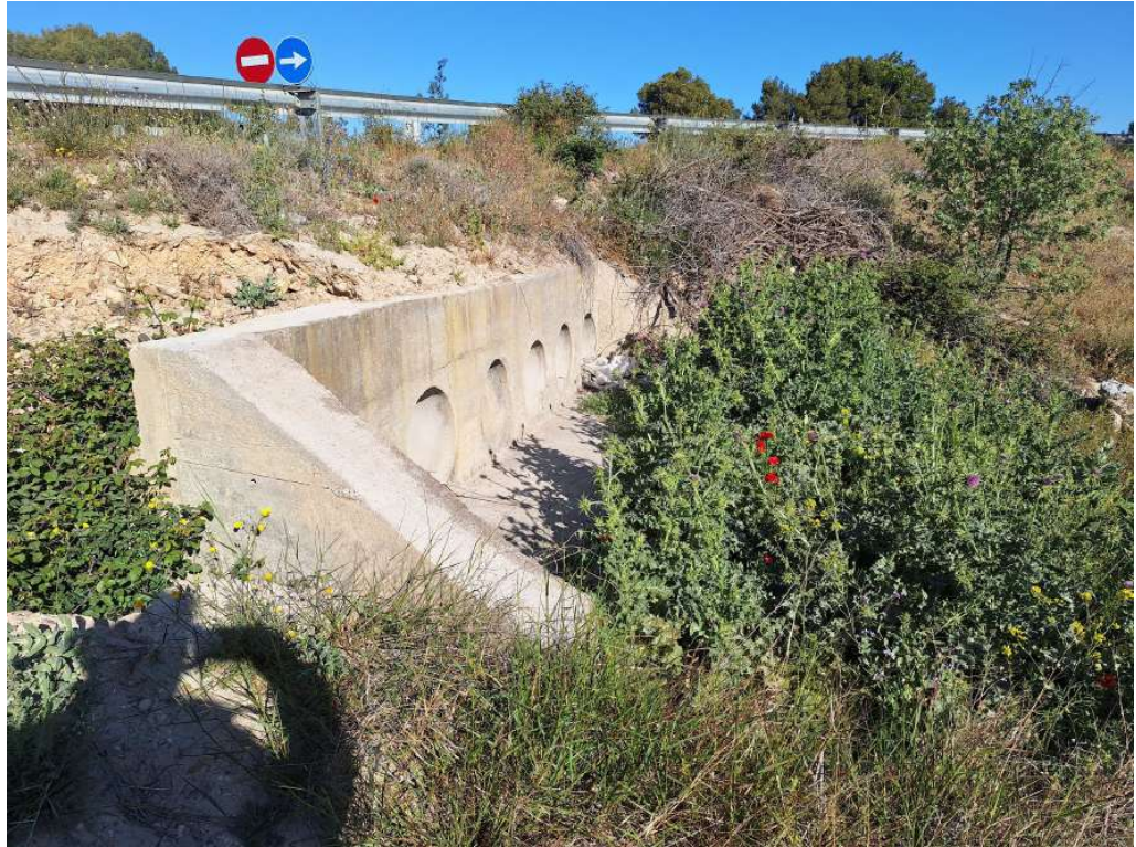
Salida del paso bajo carretera de acceso a INSIDER.
