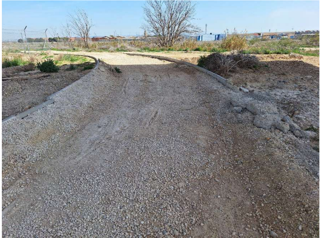
Zona de tránsito de caudales hacia Viaducto AVE.
