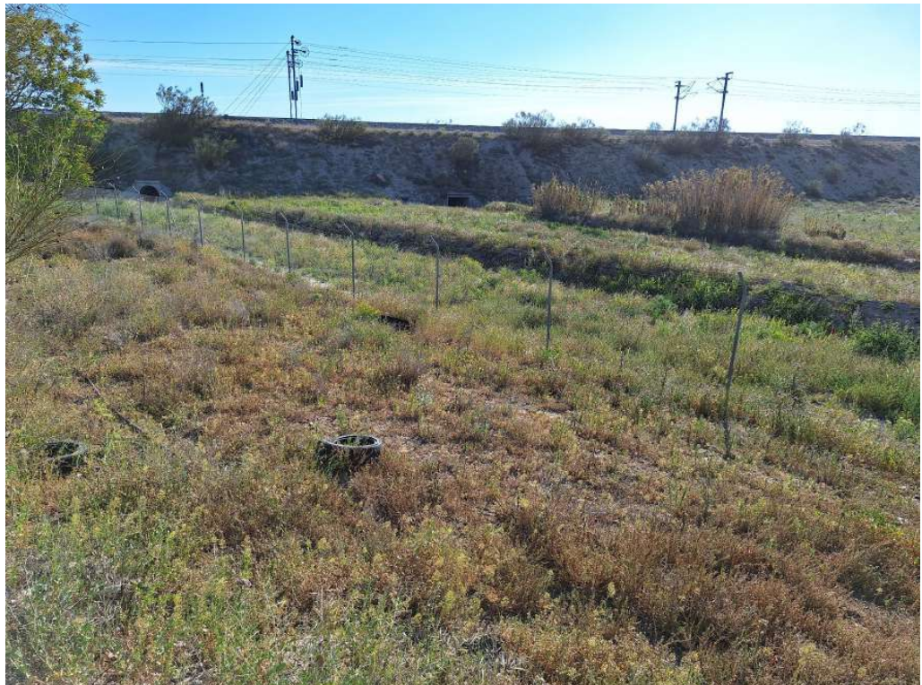
Vista de los teóricos paso del barranco bajo el AVE.
