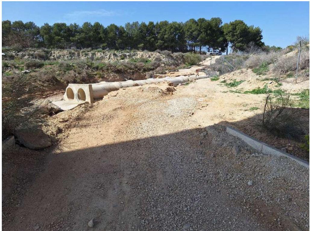
Vista de los tubos de drenaje del camino del Anillo Verde. Los de hormigón diámetro 800 y los corrugados de diámetro 900.
