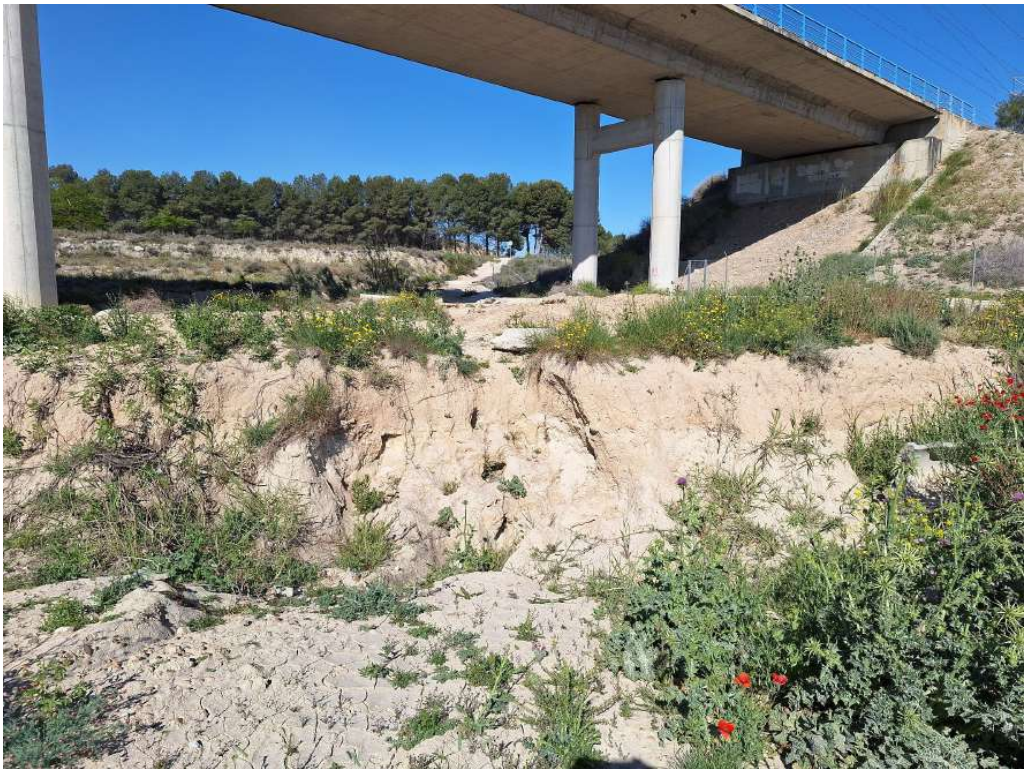
Arrastres y erosiones bajo el Viaducto AVE.
