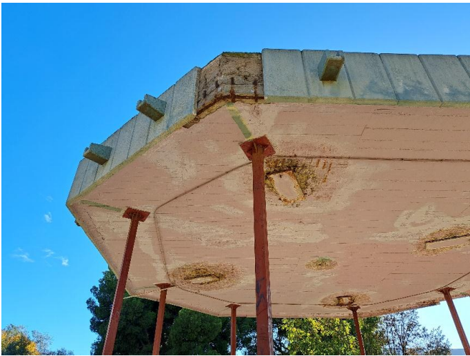
Aspecto de la cubierta. Fuente: EUROTEC.
