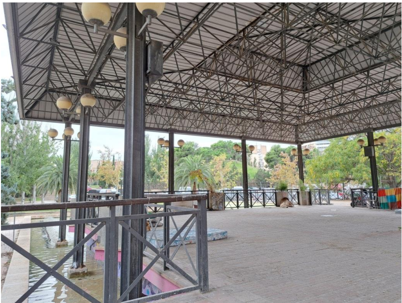
El vallado y unos dados de obra que tiene el perímetro no se demolerán. Fuente: EUROTEC.
