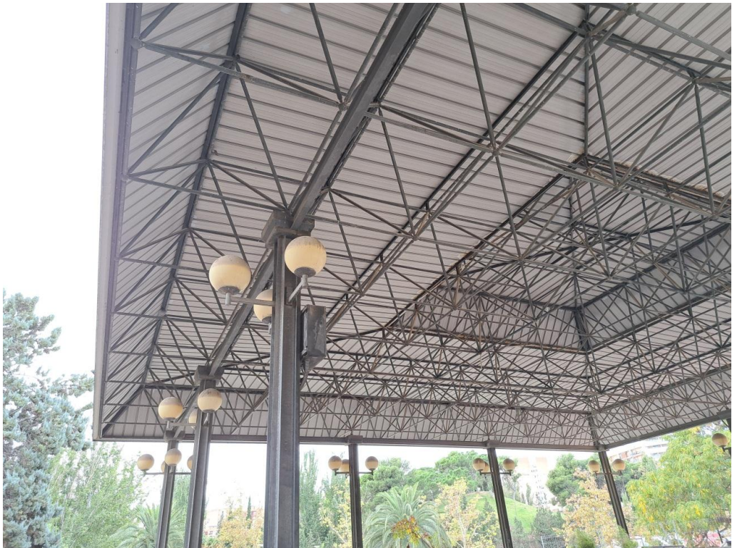
Aspecto de la cubierta espacial. Fuente: EUROTEC.
