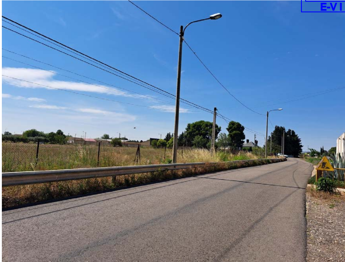
Imagen 3. Tramo 3 con luminarias de vapor de sodio de alta presión.
