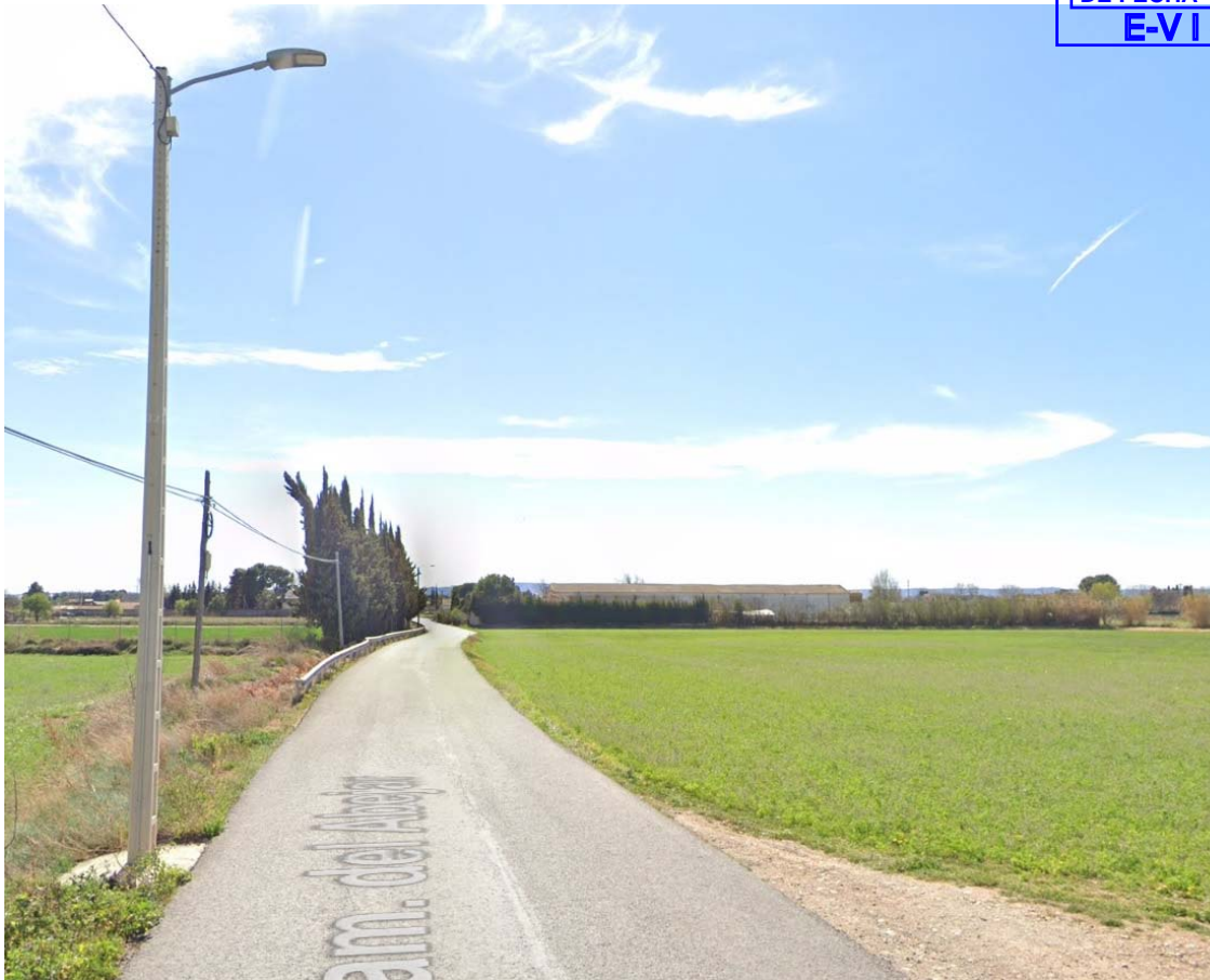
Imagen 2. Tramo 2 sin iluminación. Se observa la última luminaria del tramo 1.
