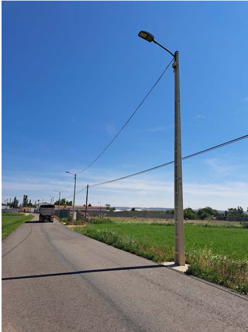
Imagen 1. Luminaria LED existente en camino del abejar. Final de tramo 1
