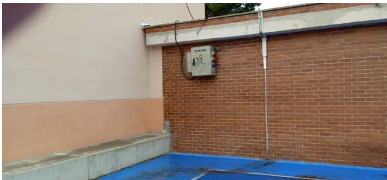
( Foto 2. Zona ubicación de la escalera de mantenimiento)
