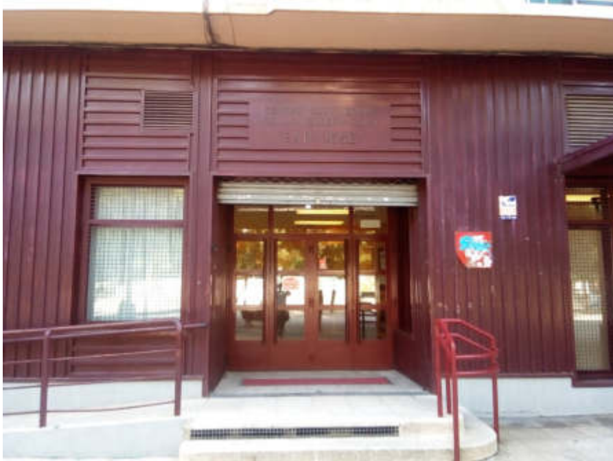
Foto 4 ( Ubicación de unidades exteriores para cafetería y aula 6)
