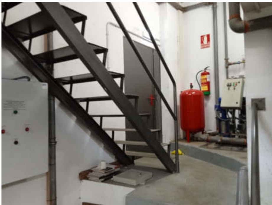
(FOTO 2 ZONA ACCESO A SALA DE MAQUINAS)
