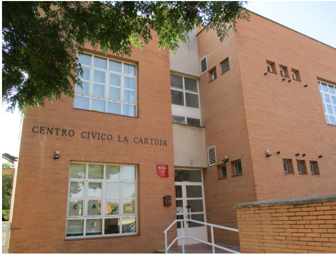
Fachada principal Centro Cívico
