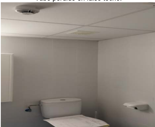
Aseo con ventilación a falso techo
