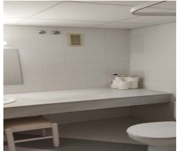
Aseo con ventilación en pared.
