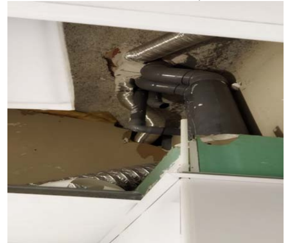
Tubo rígido a cubierta en 3º planta
