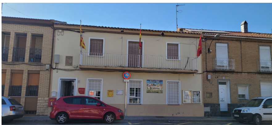
Vista general del edificio. Cubierta a dos aguas.
