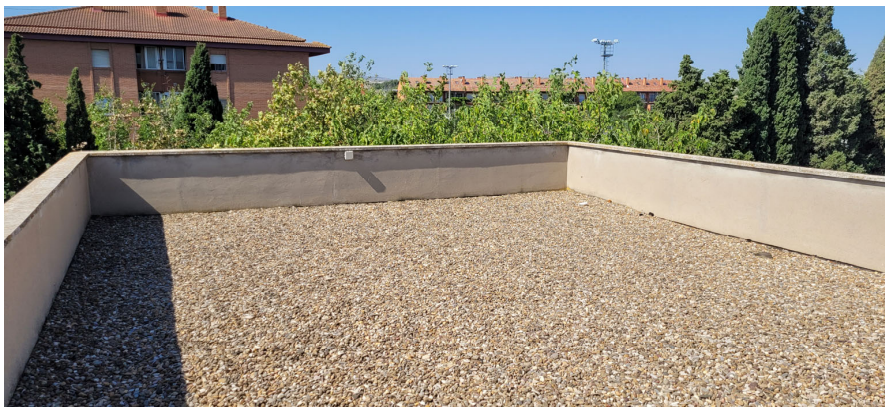
Antepecho perimetral. Recerco hasta 1,10 m de altura.
