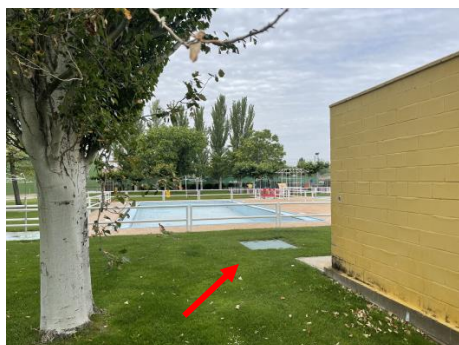
Arqueta de aljibe vaso piscina infantil
