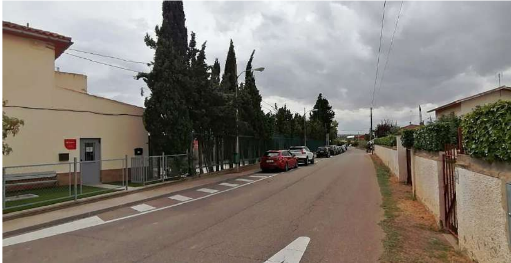
Imagen 4. Luminarias existentes Camino del Tomillar (tramo desde Plaza Mayor).
