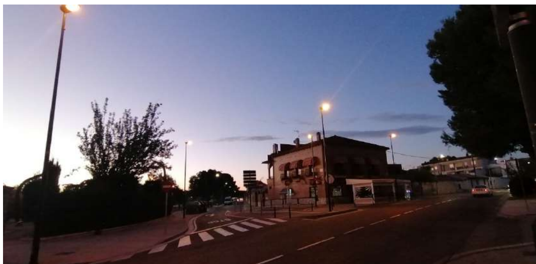
Imagen 8. Luminarias existentes en el cruce entre Avda. San Gregorio y calle Cristo Rey.
