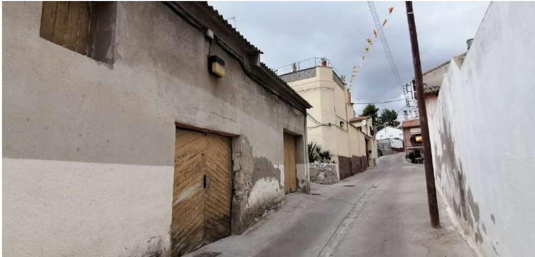
Imagen 3. Luminarias existentes en la calle Barrio Bajo del Barrio Alfocea
