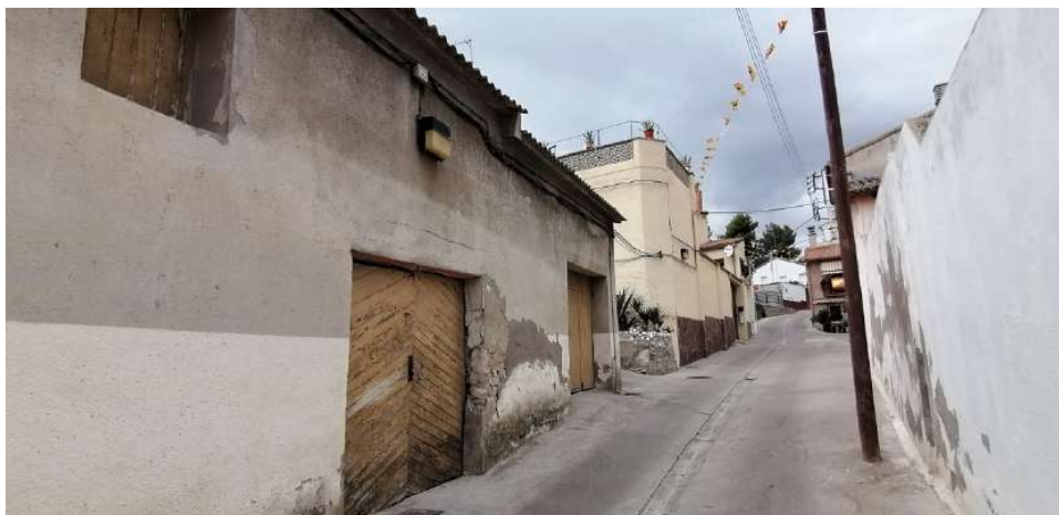
Imagen 3. Luminarias existentes en la calle Barrio Bajo del Barrio Alfocsa
