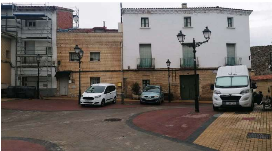
Imagen 1. Luminarias existentes Plaza de España Barrio Alfocsa
