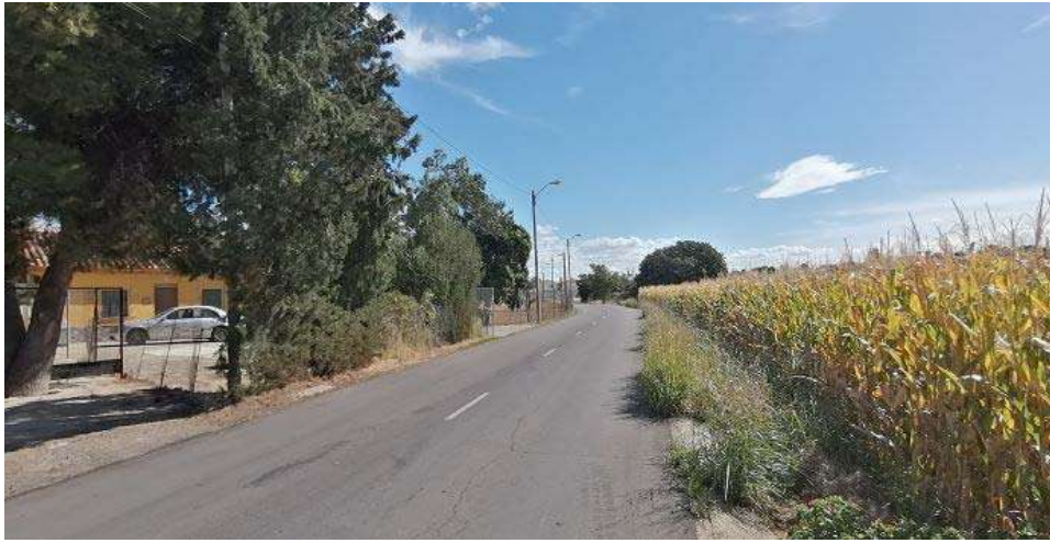
Imagen 5. Luminarias existentes en Camino de Pinseque.
