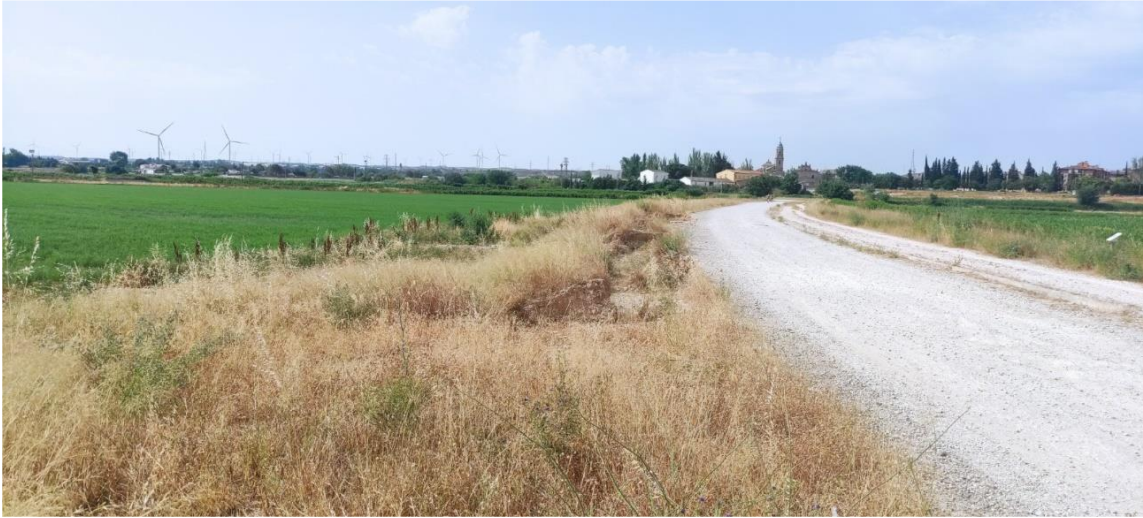
Ilustración 1 Vista general talud camino
