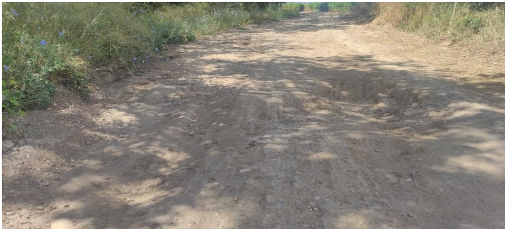
Ilustración 3 Zona bacheada en final de tramo
