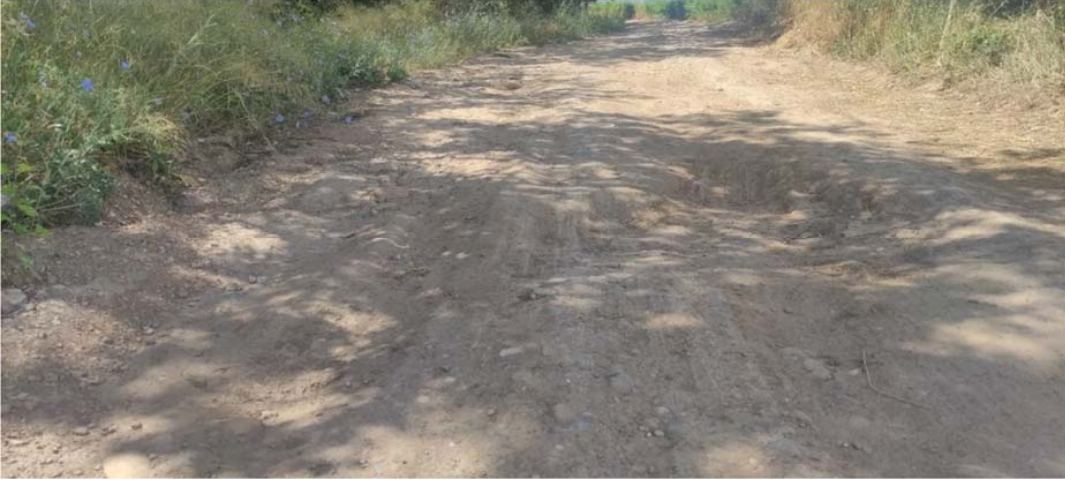
Ilustración 3 Zona bacheada en final de tramo
