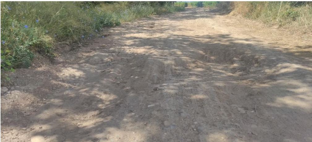
Ilustración 3 Zona bacheada en final de tramo
