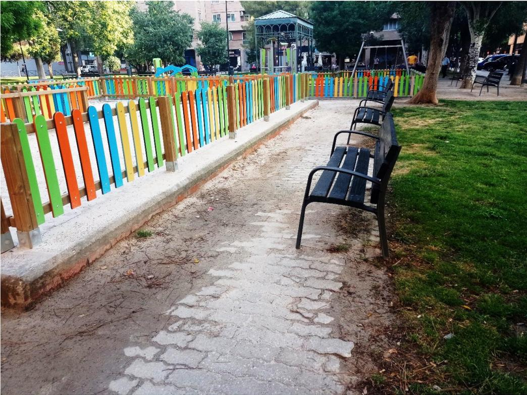
Foto 7.- Zona de adoquín de hormigón a sustituir por hormigón lavado.
