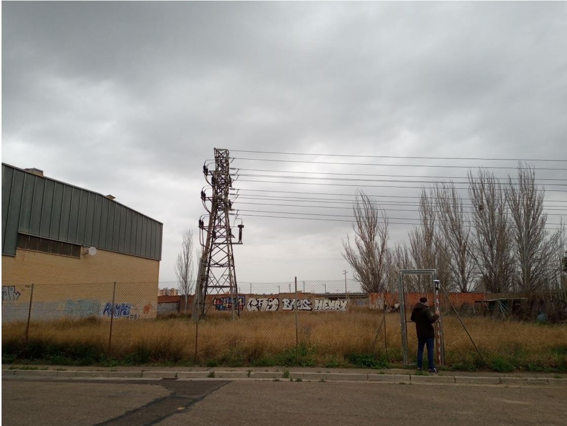
Vista general de la parcela desde el exterior, donde se aprecia el cerramiento perimetral, la torre eléctrica de alta tensión y el edificio de ENEL contiguo.
