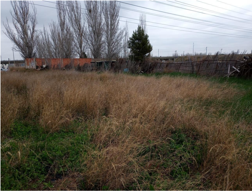
Límite este de la parcela, con un cerramiento en mal estado y un huerto particular colindante.
