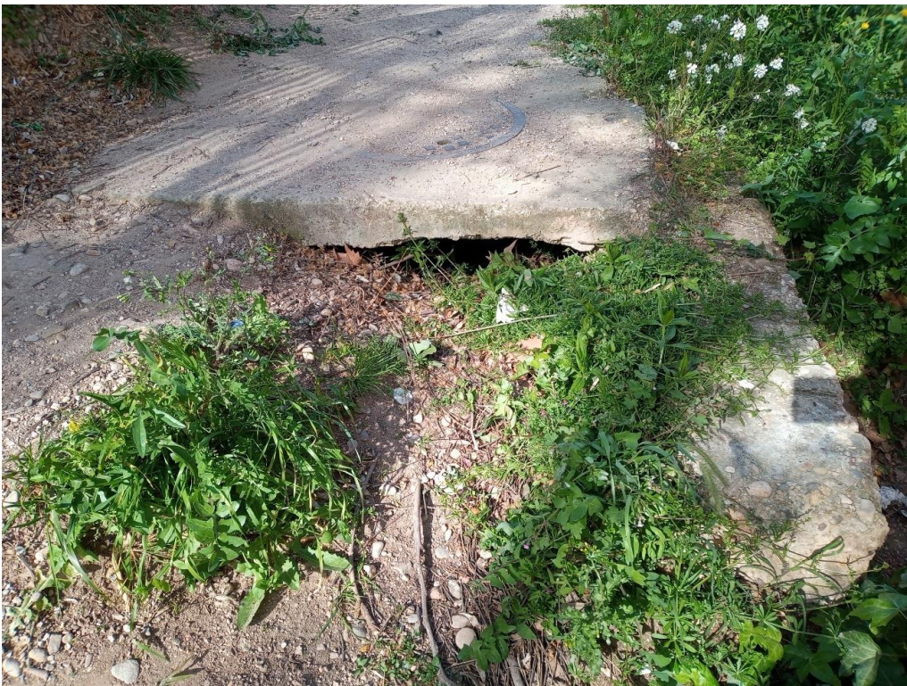
Tramo de acequia aparentemente abandonado, y arqueta.
