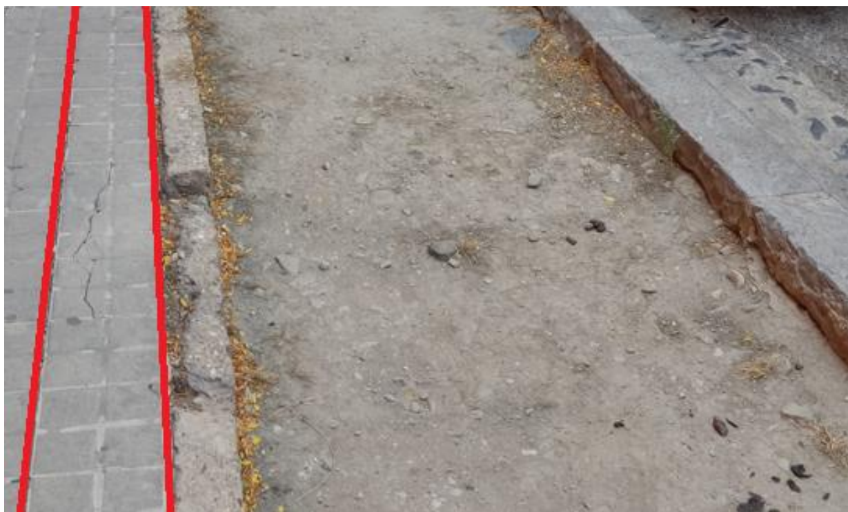
Ilustración 3 Franja de baldosa a demoler y reponer
