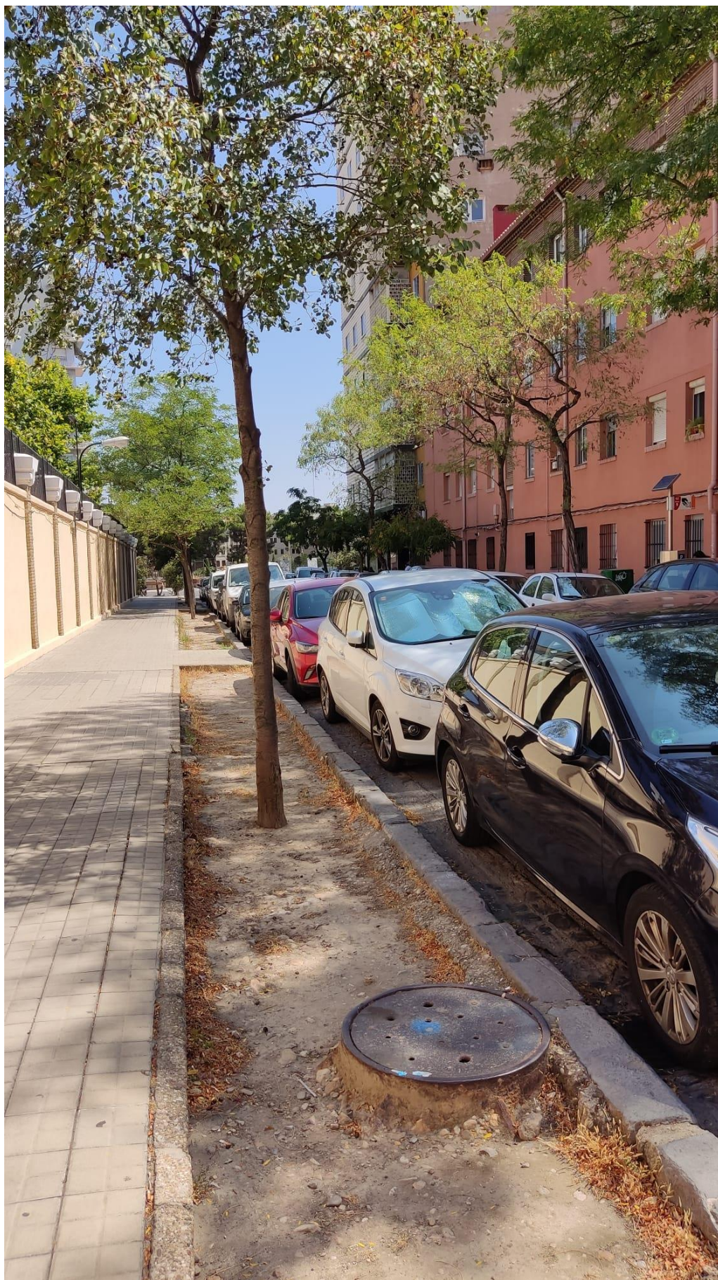
Foto nº 5.- Pozo de saneamiento en platabanda
