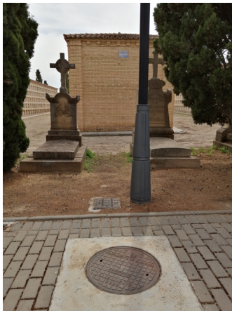
Red municipal de saneamiento existente
