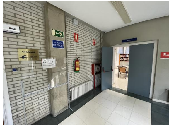
Final de pasillo III con acceso a biblioteca
