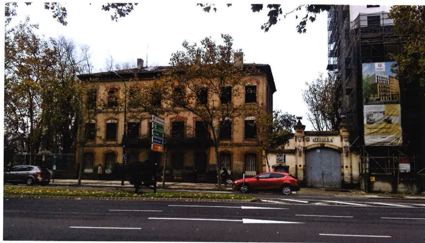
Vista desde Paseo María Agustín. Edificio de Viviendas y acceso.
