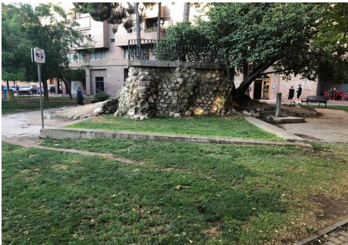
Estado actual del mirador de la Plaza Reina Sofía.
