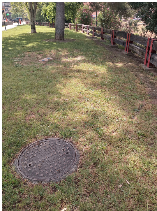
Abastecimiento y saneamiento para conectar la fuente.
