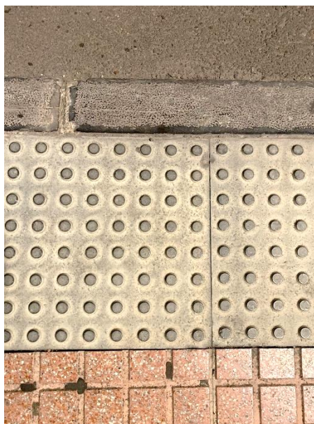
Imagen 2: Suelo de baldosa hidráulica podotáctil
