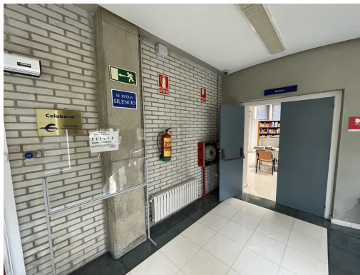
Final de pasillo III con acceso a biblioteca
