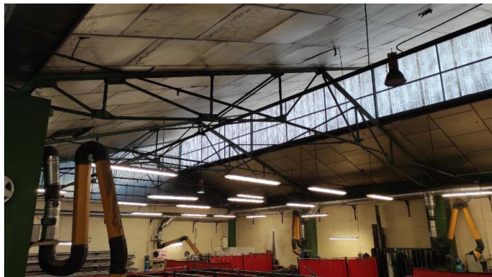
( FOTO 3. ZONA INTERIOR DE LA NAVE)
