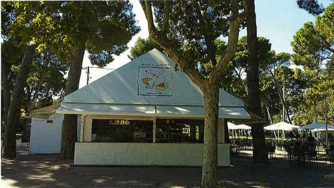
Vista general de la parte delantera del edificio y zona de terraza exterior a ambos lados.
