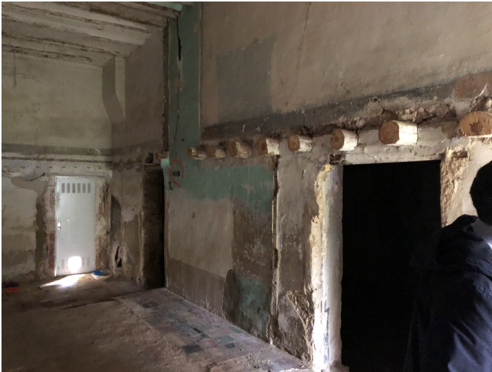
Estado actual: pavimento de planta baja
