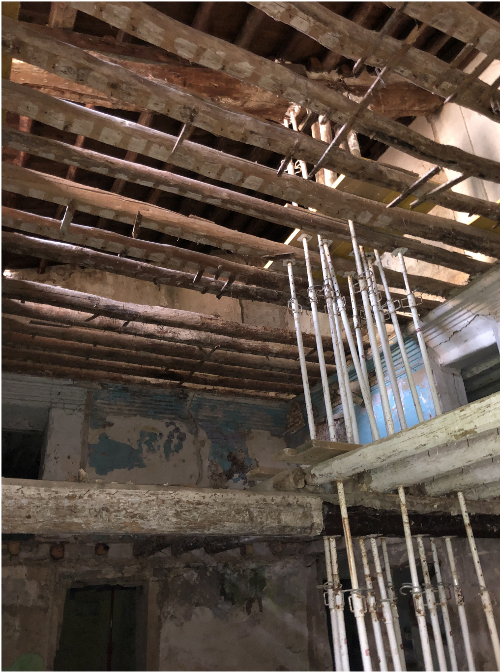
Estado actual: cubierta del volumen principal desde planta baja
