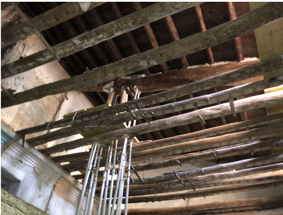
Estado actual: cubierta del volumen principal desde planta baja
