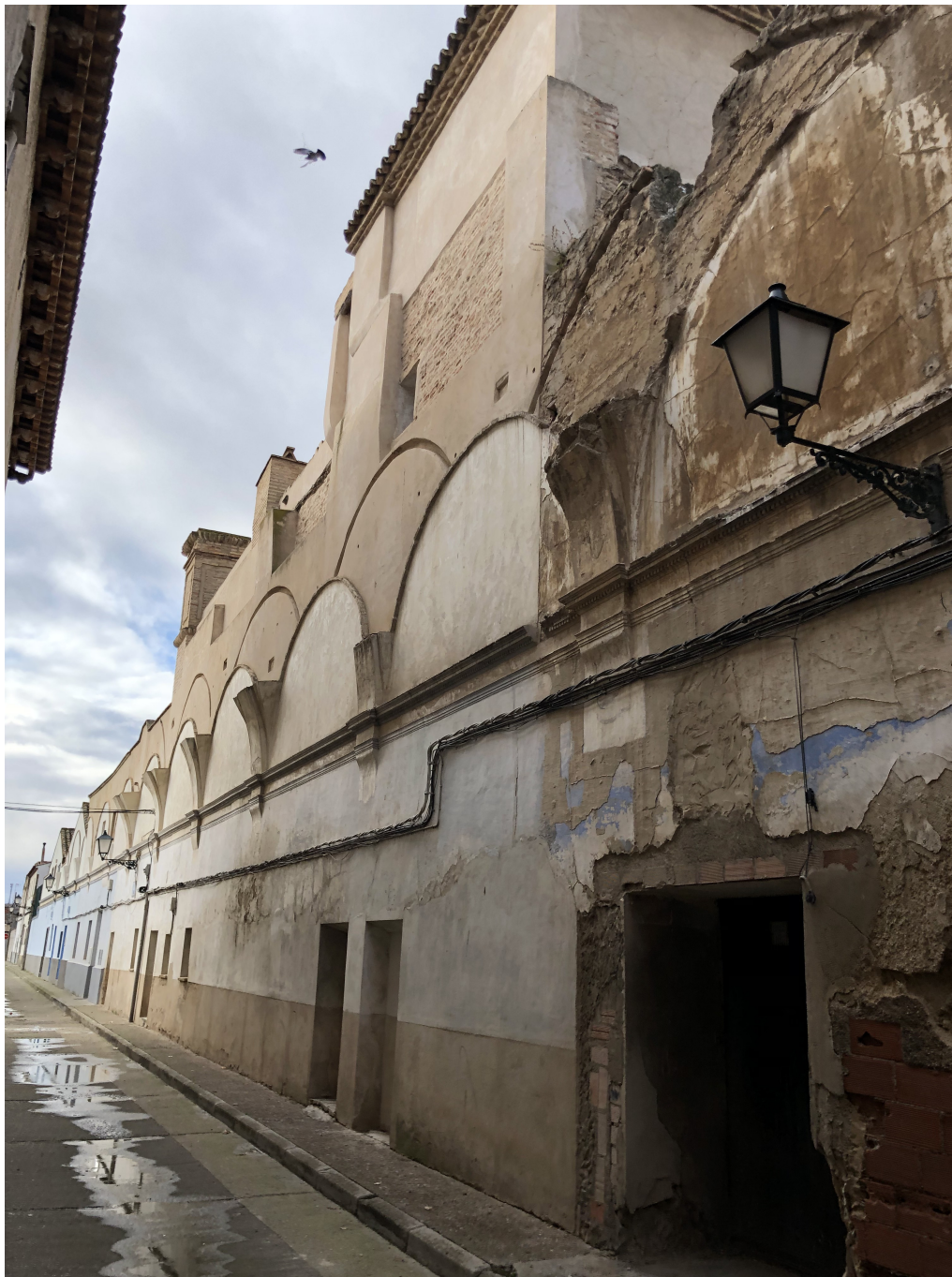
Estado actual: fachada posterior
