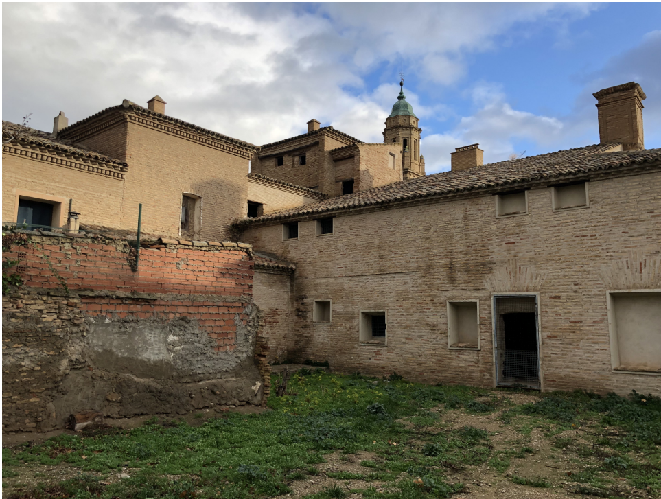
Estado actual: fachada y cubierta del volumen principal desde patio de acceso.
