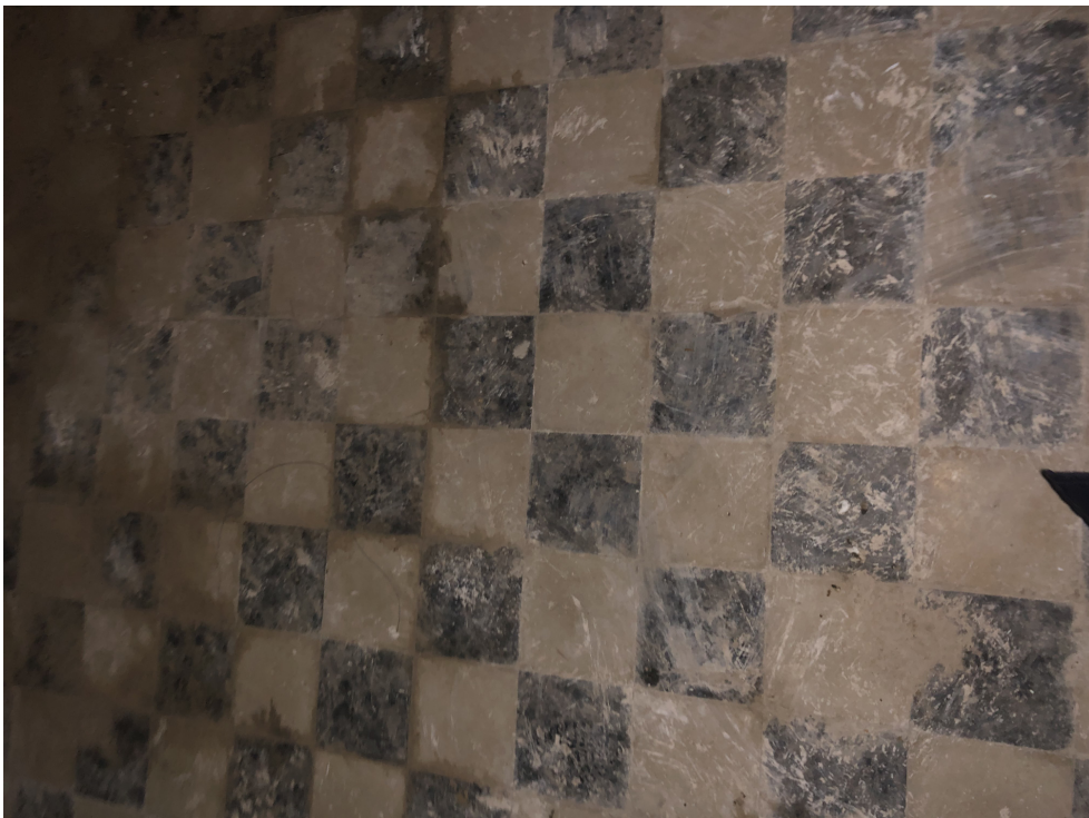
Estado actual: pavimento de planta baja
